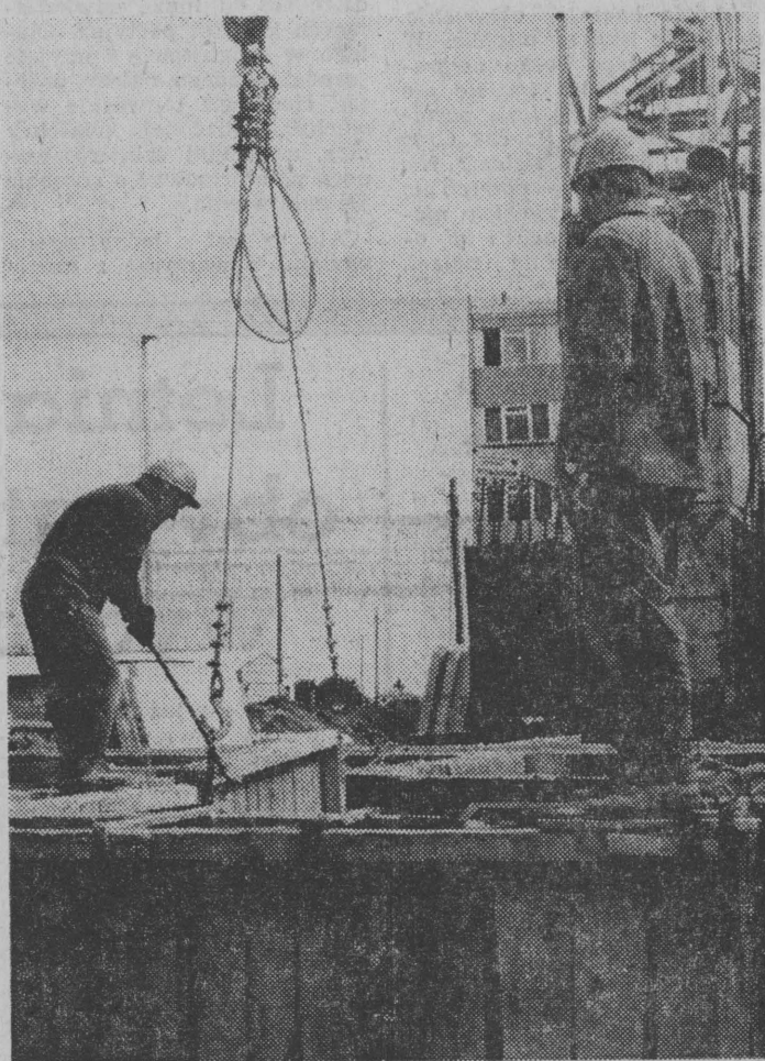
NA ZDJĘCIU: brzygadziści Stanisław Zubrzycki i Alfons Wasilewski z Elkiego Przedsiębiorstwa Budowlanego podczas rozbiórki szalunków wznoszonego bloku.
