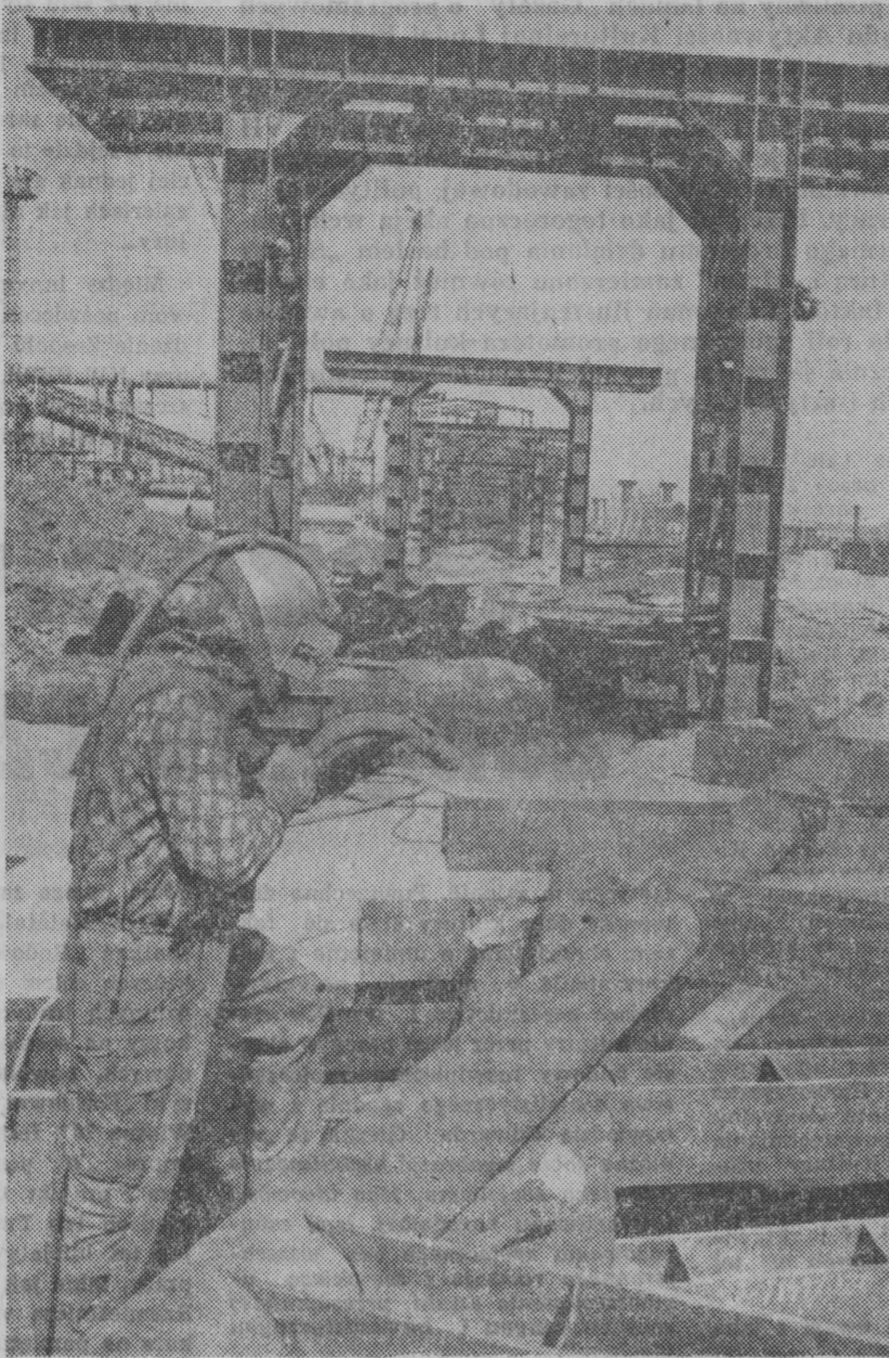
Andrzej Lewandowski z krakowskiego Przedsiębiorstwa Robót Wykończeniowych czyszczy konstrukcje przeznaczone do malowania. CAF-Seko
