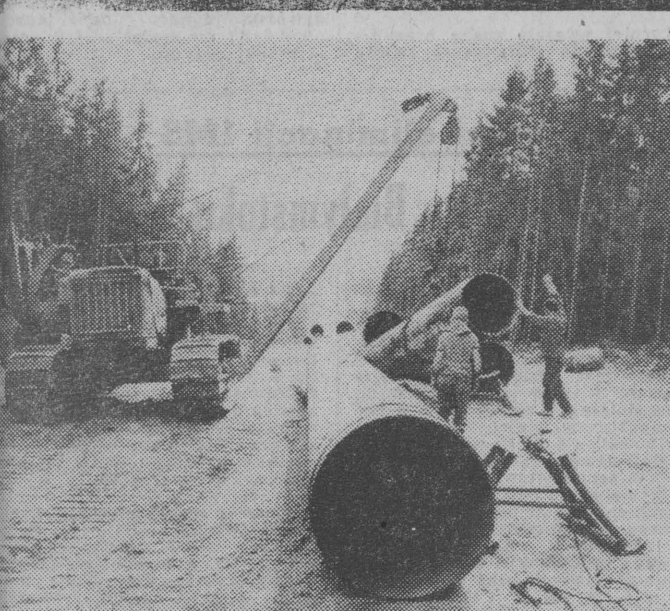
Na terenie Czechosłowacji trwają prace przy budowie drugiej nitki 1100 km gazociągu tranzytowego, którym rakiety satelitarne dostarczany jest zarówno do CSRS, jak i do innych krajów — NRD, Austrii, Włoch i RFN. Od chwili uruchomienia rurociągu w 1973 r. „przepłynęło” nim 25 mln sześć. gazu.
