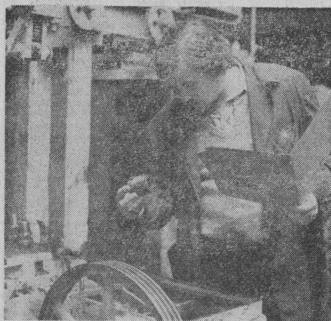
Mistrz, inż. Roman Marczenko sprawdza jakość wykonanego remontu prasy hydraulicznej do tytoniu.
