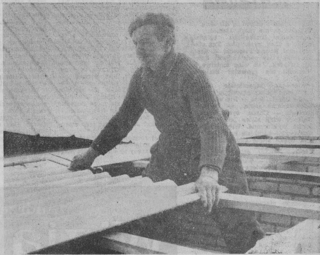
Rolnik powinien umieć wszystko zrobić — mówi Jan Kamiński, pokrywając dach nowego budynku.
