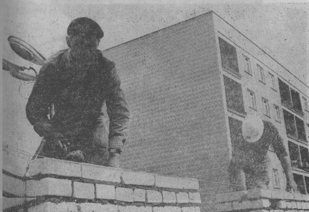
MONKI. Z każdym rokiem miasto pięknieje. Monieckie place budów obiektów mieszkaniowych, przemysłowych i oświatowych to stanowiska robocze załogi Podlaskiego Przedsiębiorstwa Budowlanego.
