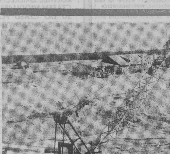
Ogromny jest plac budowy ZPW w Grajewie. Na dalszym planie widać rabinów.
