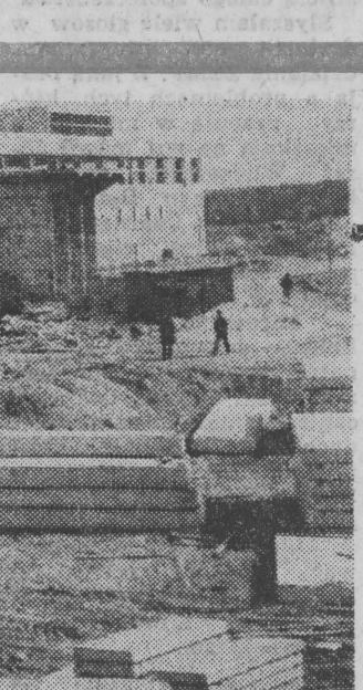
Ogromny jest plac budowy ZPW w Grajewie. Na dalszym planie widać rabinów.
