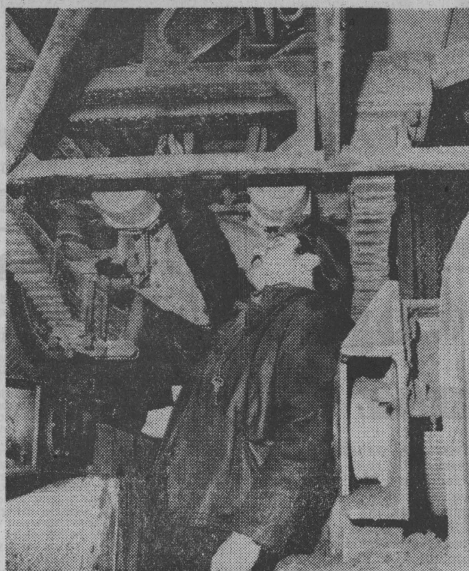
Elektryk, Eugeniusz Łukasz, dokonuje kolejnej naprawy.
