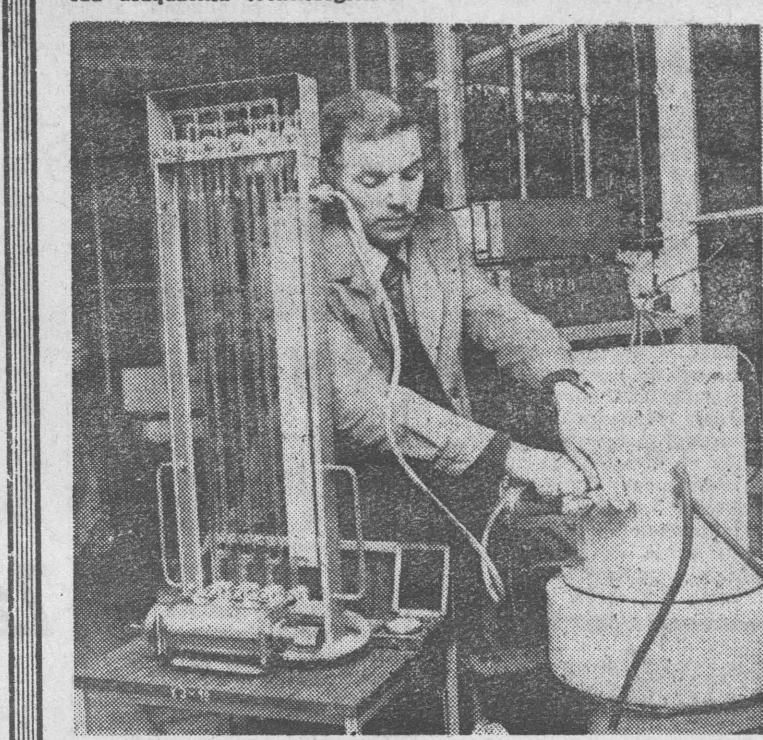
NA ZDJĘCIU: Konrad Zbieralski reguluje stanowisko do próżniowej metalizacji tworzyw sztucznych.
