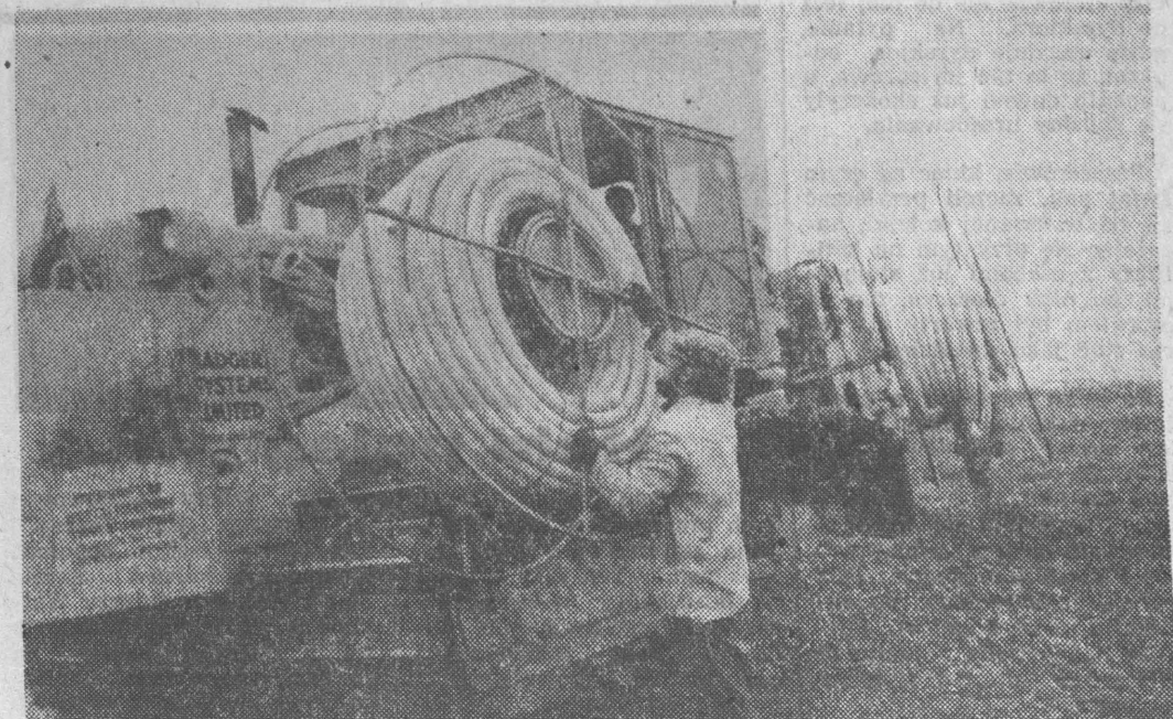
Jesien to okres wzmożonych prac melioracyjnych. Chodzi o to, by przed nadejściem mrozów zagospodarować jak największą część pól, łąk i drzew. Prace te z każdym rokiem są bardziej zmechanizowane. Na polach PGR Wondajny w okolicach Kostrzyna zakładają się drenaż na 600-hektarowym obszarze przy pomocy nowoczesnej maszyny „Bander”. Ten importowany „gigant” kopie rowy, układa specjalne plastikowe drenaż i zasypuje je ziemią. Maszyna zastępuje 200 robotników, drenażując dziennie 10 ha. Obsługują ją specjalnie przeszkoleni kierowcy pod okiem inż. Krzysztofa Różańskiego.
