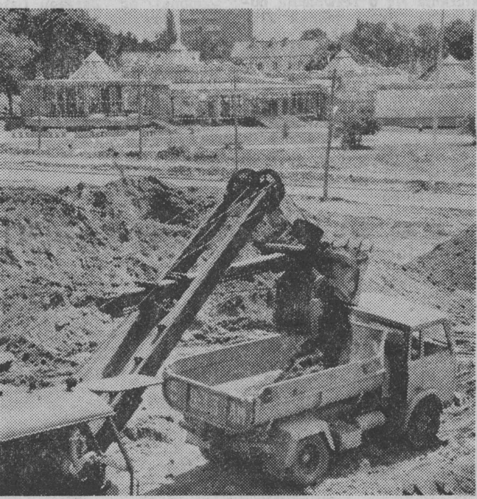
Prace ziemne związane z budową pierwszego w naszym mieście podziemnego przejścia dla pieszych. Fot. Z. Lenkiewicz
