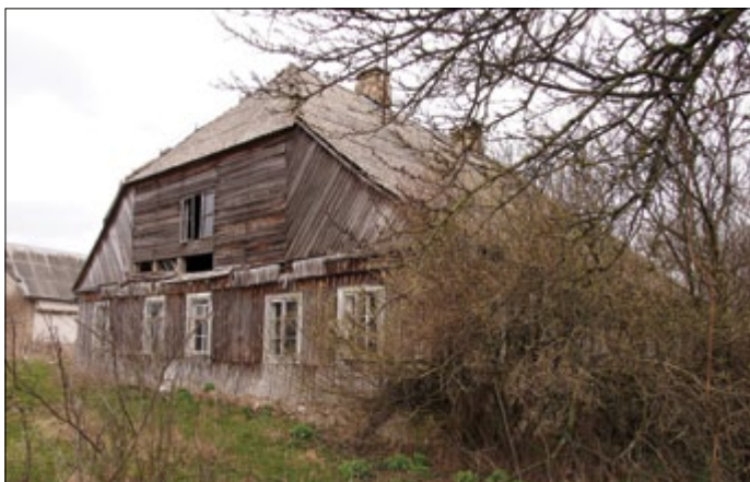
Elewacja boczna dworu w Sikorach
