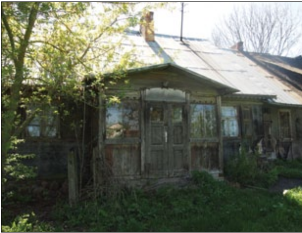
Fragment elewacji frontowej dworu w Łabętniku
