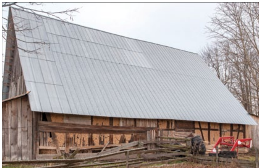
Stodoła o konstrukcji szachulcowej, Kolonia Dubasiewskie, gm. Suchowola
