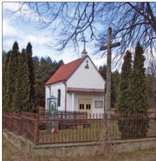
Kaplica na miejscu kaźni w Jasionowie
