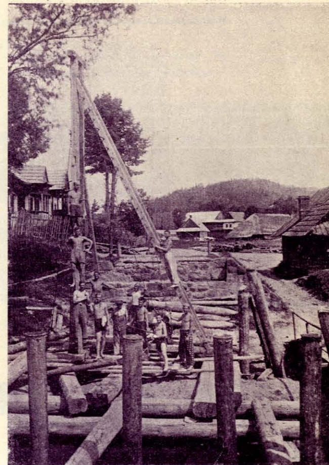
Budujemy mosty. Grupa uczestników obozu pomorskiego w Jordanowie przy naprawie zerwanego przez powódź mostu na Skawie.
