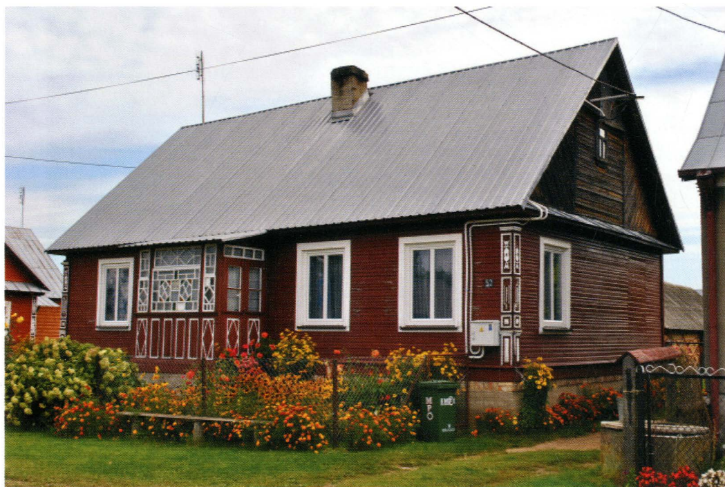
13. Dom nr 52 z dekoracyjnym gankiem. House no. 52 with a decorative porch.
