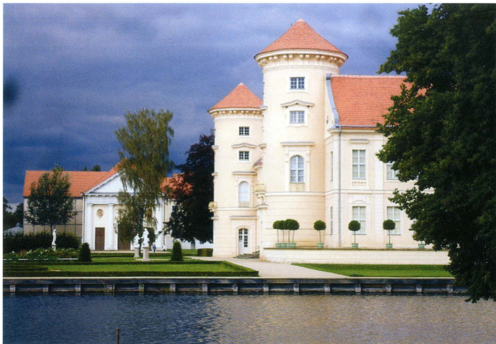
80. Rheinsberg w Prusach, ogród pałacowy, brzeg kanału wyłożony kamiennymi płytami. Fot. K. Przylicki, 2012.
