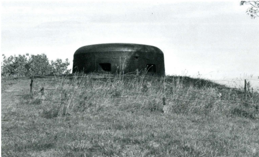
5. Schron katalogowy Regelbau 113d w Bakalarzewie, kopuła 20P7. Catalogue bunker Regelbau 113d in Bakalarzewo, cupola 20P7.
