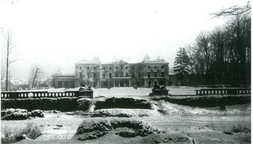
50. Odslonięte relikty mostu ogrodowego, widok w kierunku pałacu ze sfinksami.
