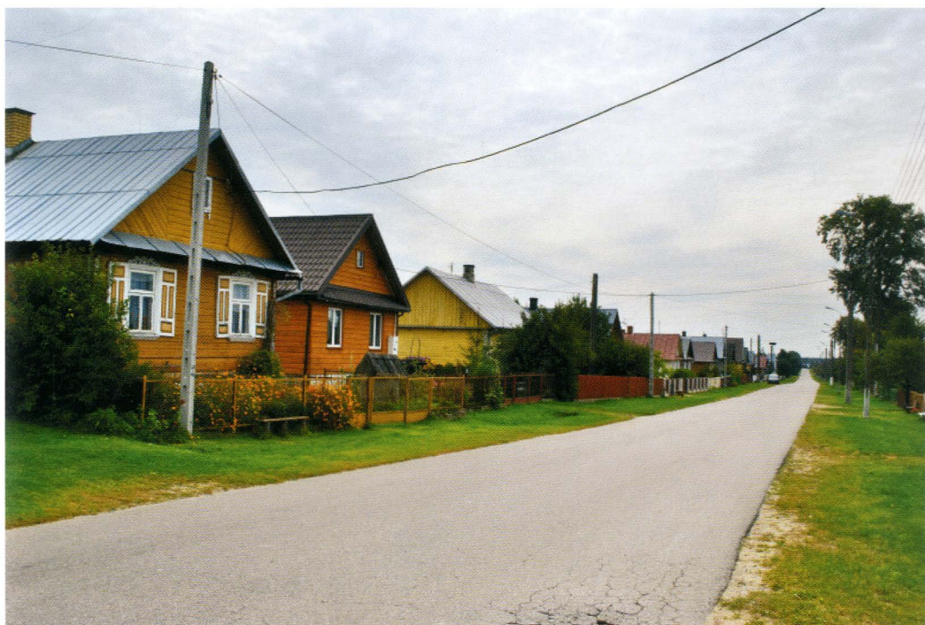
6. Widok na wschodnią część wsi od północy. View of the eastern part of the village from the north.
