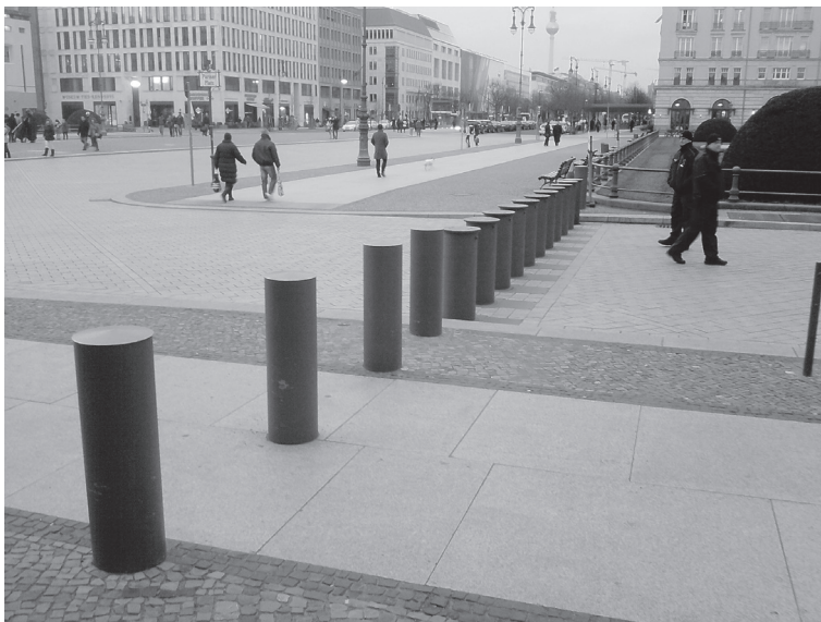
Ryc. 2.8. Elementy chroniące przed atakiem przy użyciu pojazdów zgodne z wymogami części 8. Standardu przed gmachem ambasady USA przy Placu Paryskim w Berlinie. Fot. autor
