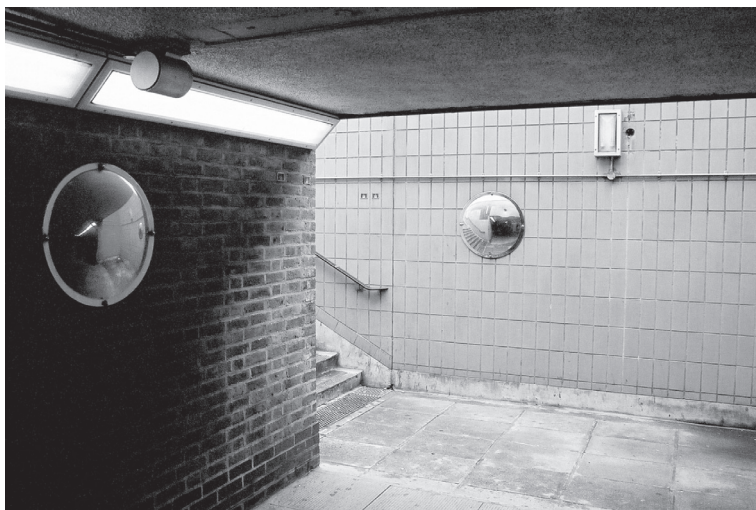
Ryc. 2.20. Zwierciadła kompensujące brak widoczności. Fot. autor
