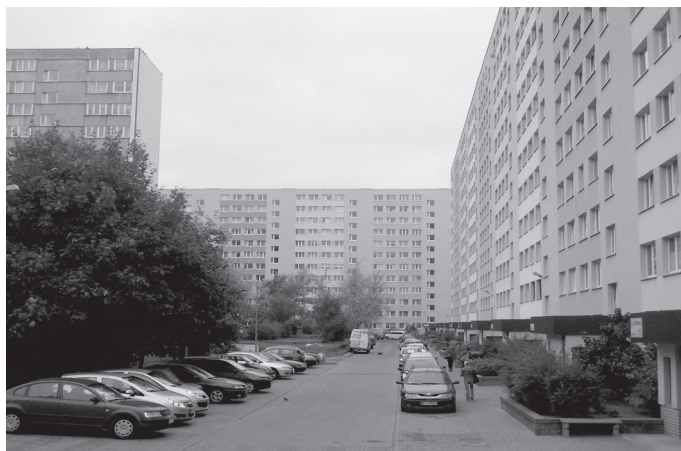
Ryc. 2.3. Zabudowa osiedla Piaski w Białymstoku
