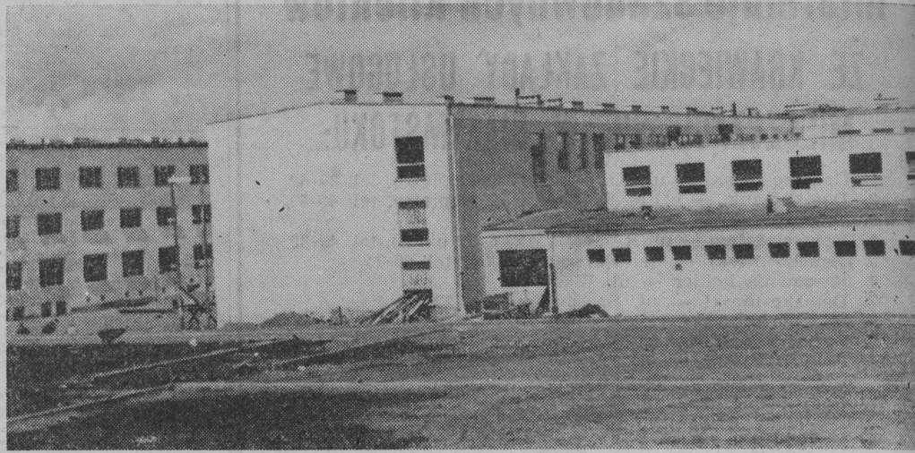
W Dąbrowie dobiega już końca budowa gmachu Liceum Ogólnokształcącego, pomnika Tysiąclecia Państwa Polskiego, przy którym znajdzie się nowoczesny internat dla młodzieży. Koszt tej inwestycji wyniesie około 14 mln złotych. NA ZDJĘCIU: fragment zespołu budynków Liceum Ogólnokształcącego w Dąbrowie. Fot. E. Hryniewicki
