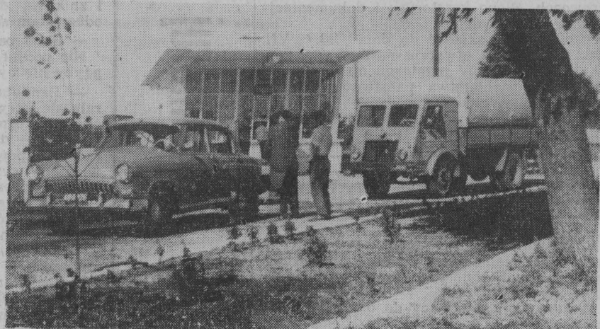
Pojazdów mamy w Białymstoku coraz więcej. Nic więc dziwnego, że nowa stacja benzynowa na Wysokim Stoczku cieszy się dużym powodzeniem.
