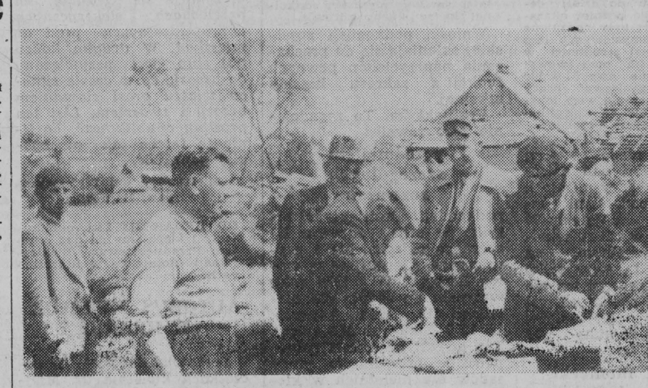
NA ZDJĘCIU: komisja PZU podczas prac w zniszczonej gromadzie Niechobitz, pow. Rzeszów. CAF — fot. Kopeć
