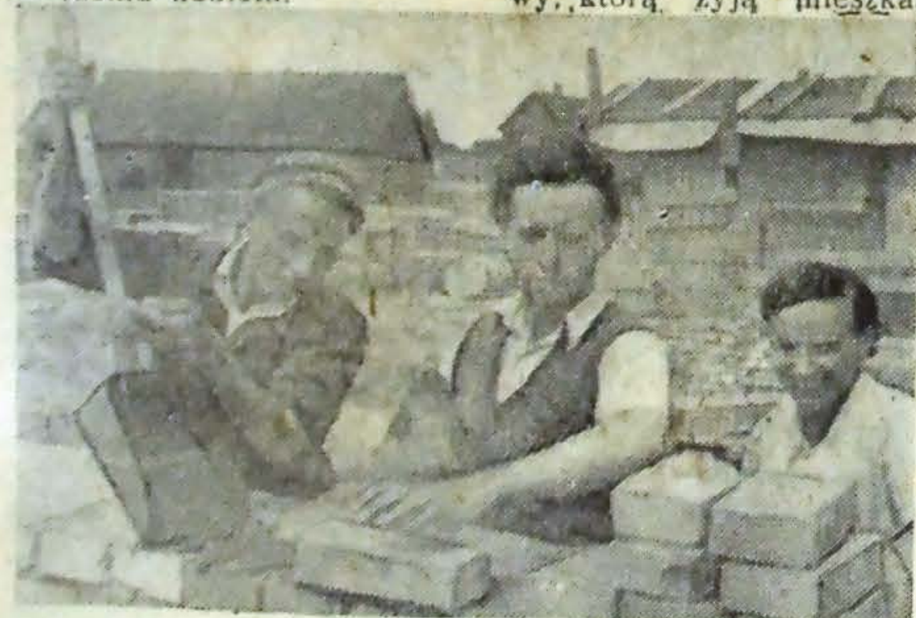
Przy budowie osiedla mieszkaniowego dla robotników kombinatu w Zambrowie pracują coraz to nowe brygady budowlane z Warszawy, Białegostoku, Łomży...
