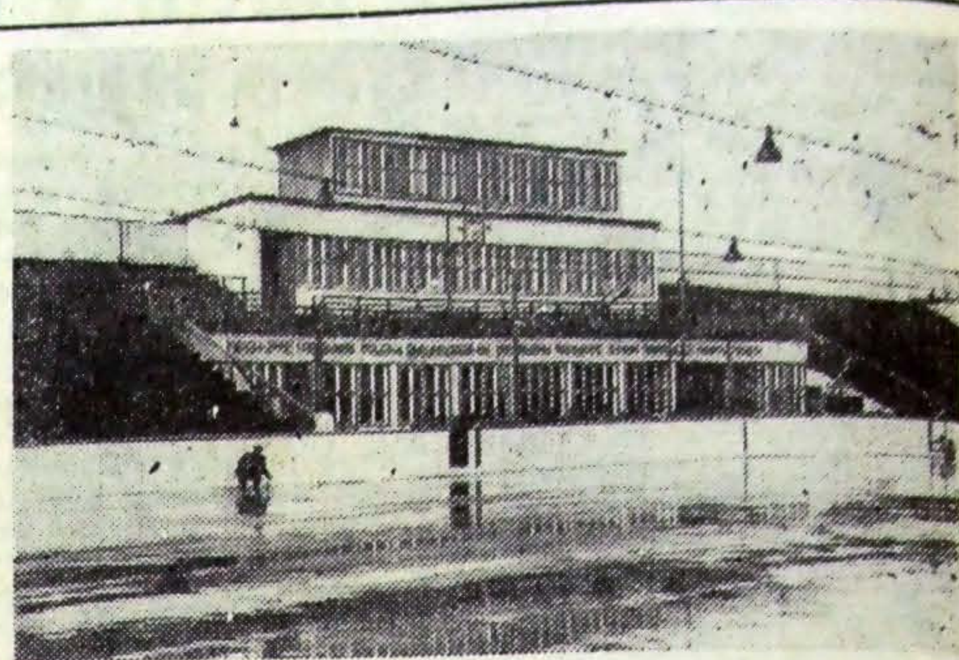
Jedynie w Polsce sztuczne lodowisko, katowicki „Torkatu”, zostało w tym roku odrestaurowane. Oficjalne otwarcie Torkatu nastąpiło 18 października br. Na zdjęciu: Widok ogólny Torkatu.
