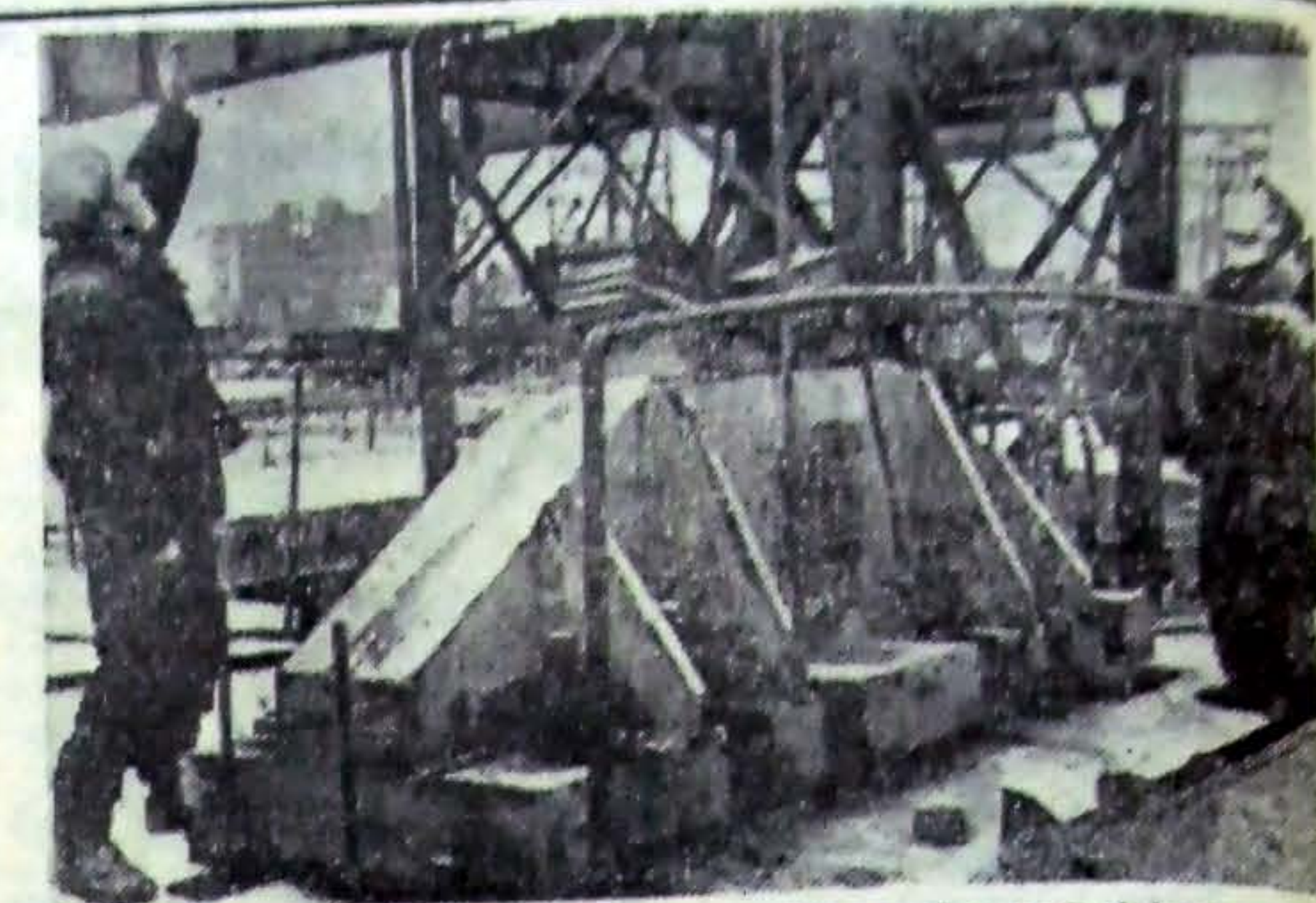
Po zakończeniu budowy fundamentów pod wysokościową część Pałacu Kultury i Nauki, radziecy budowniczowie przygotowują się obecnie do rozpoczęcia montażu stalowej konstrukcji wielkiego gmachu.
