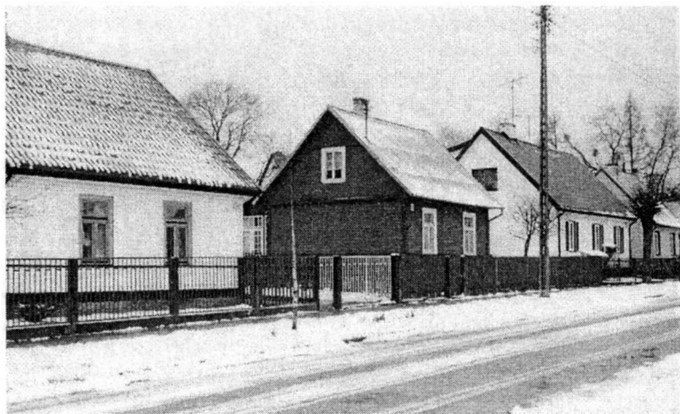
Ilustracja 2. Zabudowa mieszkaniowa ul. Dolnej, pochodząca z okresu międzywojennego (stan obecny). Fot. autor.
