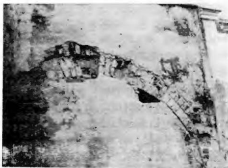
Ryc. 8. Krasnybór, pow. Augustów. Fragment elewacji północnej. Widoczny odkuty spod tynku łuk i pacha sklepienia dawnej celi-przybudówki.
