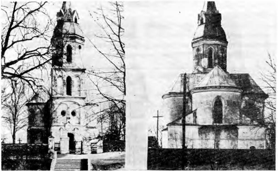
Ryc. 6. Krasnybór, pow. Augustów. Elewacja frontowa i wschodnia kościoła Zwiastowania NMP.
