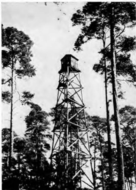
Ryc. 8. Lipowiec, pow. Augustów. Wieża przeciwpożarowa.
