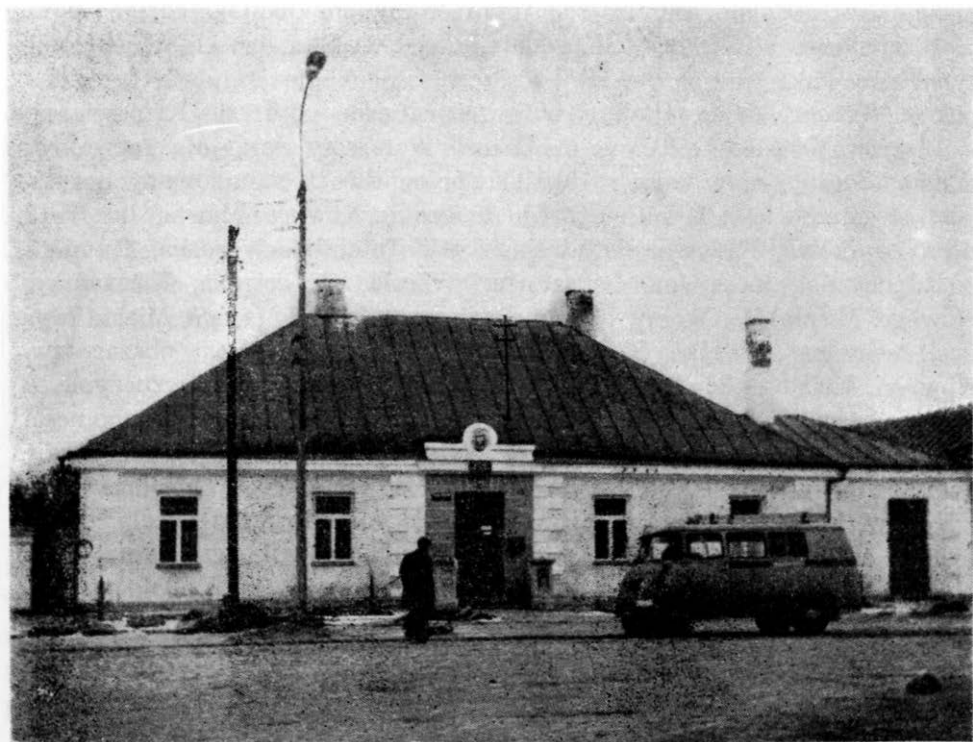
4. Szczuczyn — budynek poczty
