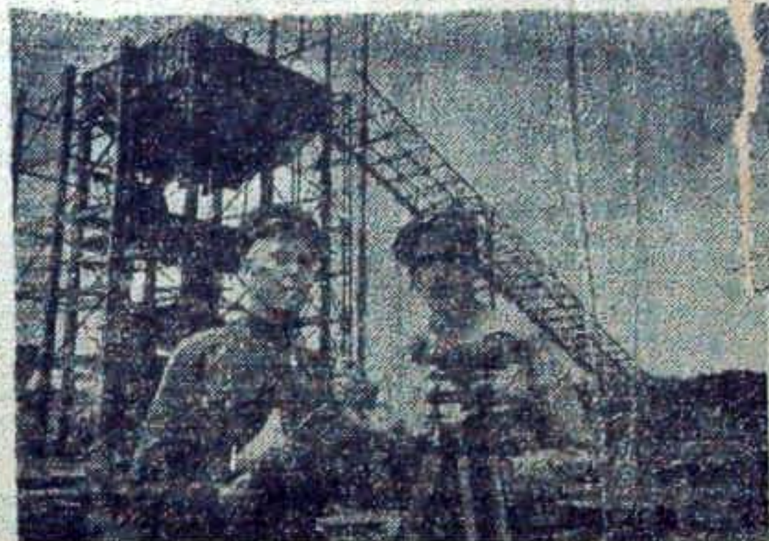
Na obu brzegach Wołgi powstają betoniarne, niezbędne przy budowie elektrowni. Na zdjęciu: Budowa największej zmechanizowanej betoniarni na lewym brzegu Wołgi. Kierownik prac N. Michalowski (po lewej) i inż. geodeta B. Sidorowicz wycieczają w terenie bocznice kolejowe. Fot. — CAF.
