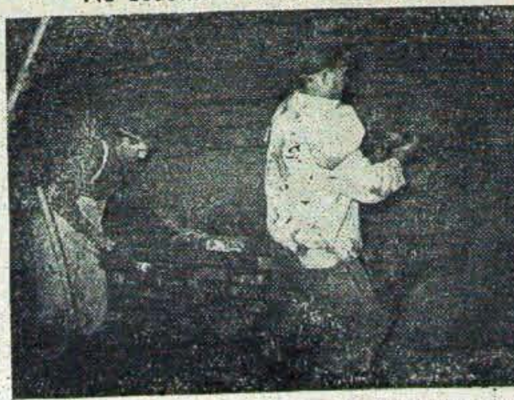
Prace przy budowie metra warszawskiego postępują w prawidłowym tempie. Na zdjęciu: Prace w szybie, drażnienie i murowanie obudowy. Przy pracy rębacz przydowy Józef Heller i rębacz Rufin Kula. CAF — fot. Nowostelski.
