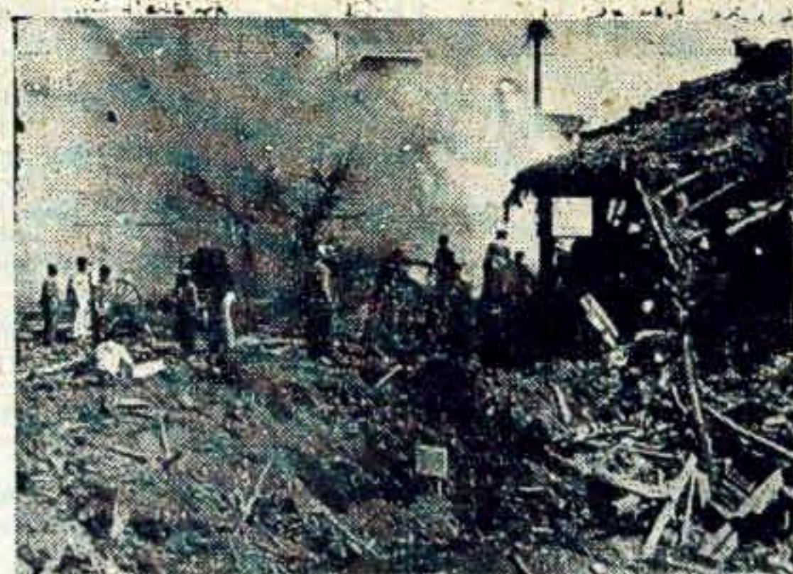
Zniszczenia w Korei.
