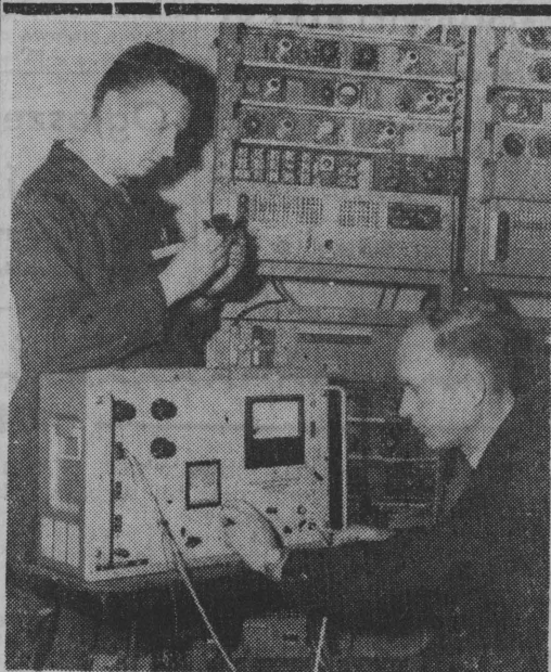
NA ZDJĘCIU: mgr inż. Kazimierz Maciejewicz i st. technik Aleksander Szczepiński przy pracy nad przeróbką urządzeń telefonii nośnej.
