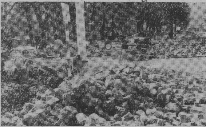
W Elku rozpoczęto przebudowę niektórych ulic. Zostaną one poszerzone oraz otrzymają nową nawierzchnię.
