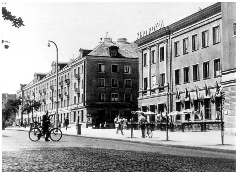
23. Zabudowa ulicy Lipowej (pierzęja północna). Na pierwszym planie kino Pokój.
