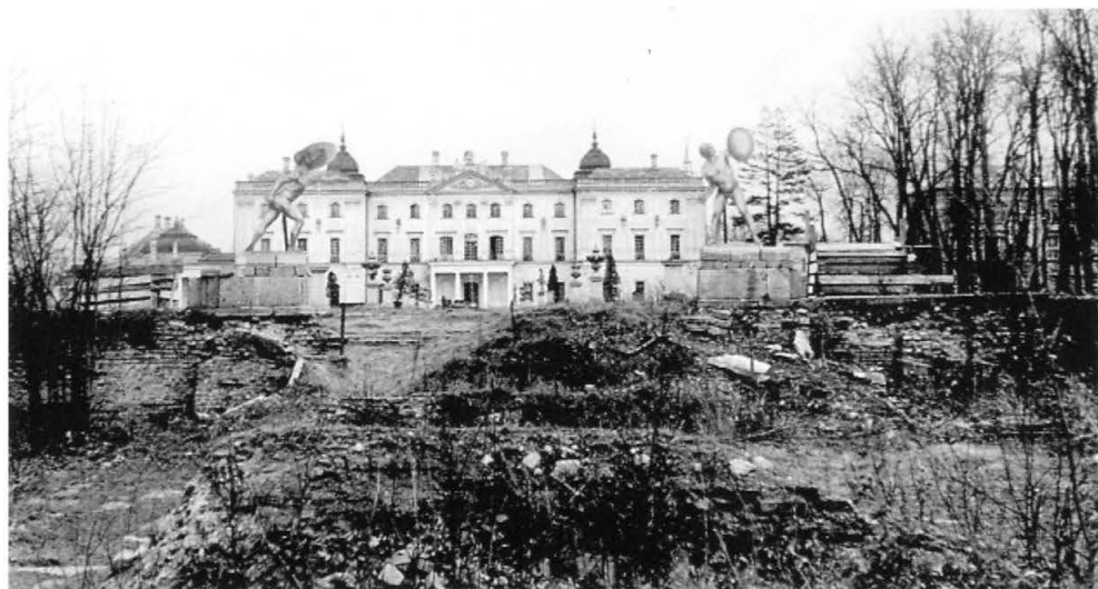
12. Pałac i ogród widziane od strony zniszczonego mostu. Widoczne figury gladiatorów to makiety. Fot. Wł. Paszkowskiego z 1957 r. w archiwum WUOZ w Białymstoku. Palace and garden seen from the destroyed bridge. The visible figures of gladiators are models. Photo: W. Paszkowski, 1957, in the archive of the Voivodeship Office for the Protection of Historical Monuments in Białystok.
