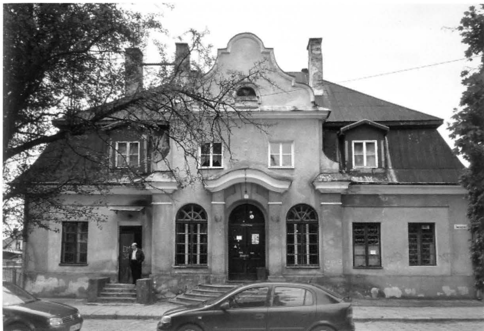
16. Mońki, elewacja wschodnia dworca kolejowego. Fot. K. Straczyński, 2012. Mońki, eastern elevation of the railway station. Photo: K. Straczyński, 2012.
