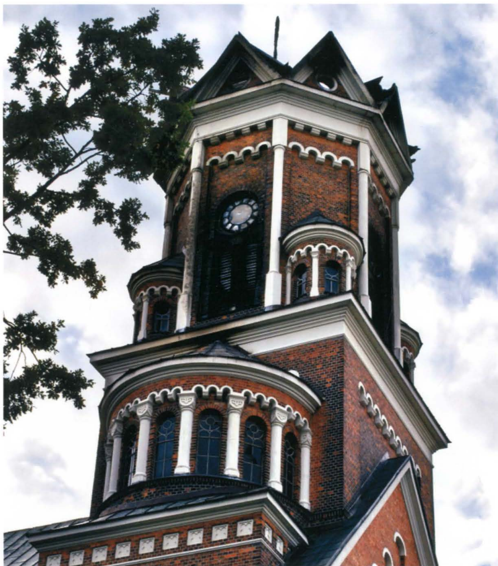
14. Wieża kościoła, stan po zawaleniu helmu, widoczne osmalenia cegieł.
