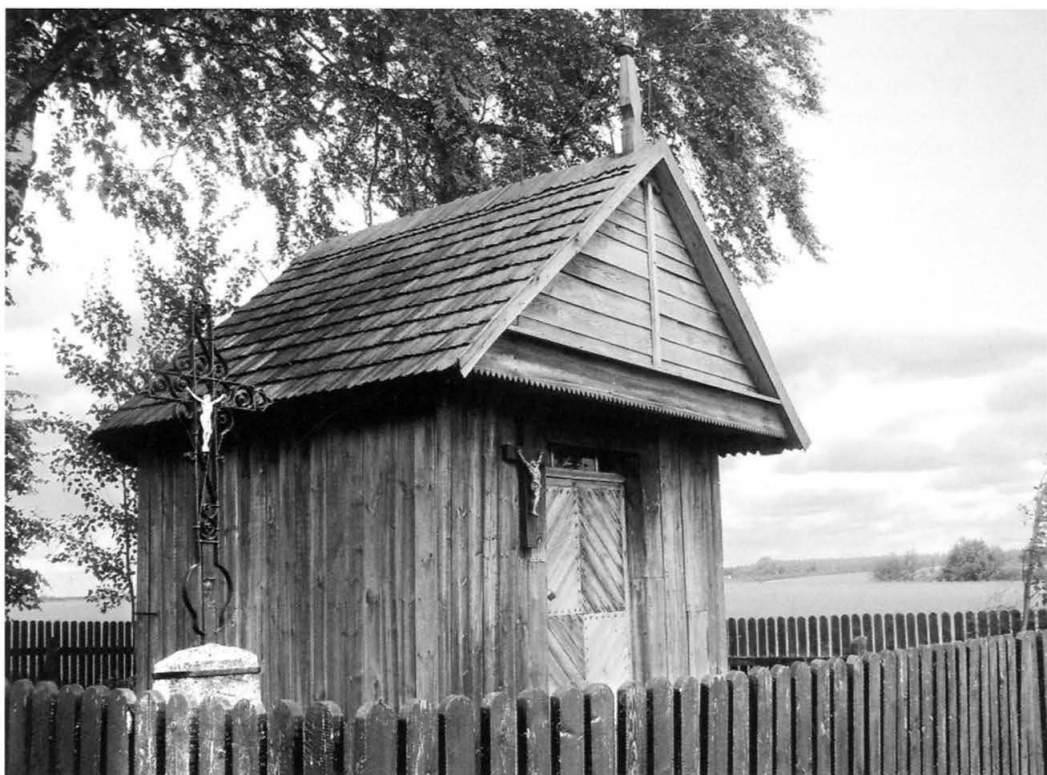
3. Kaplica od strony południowo-wschodniej. Fot. J. Drozdowska, 2011. Shrine from the south-east. Photo: J. Drozdowska, 2011.
