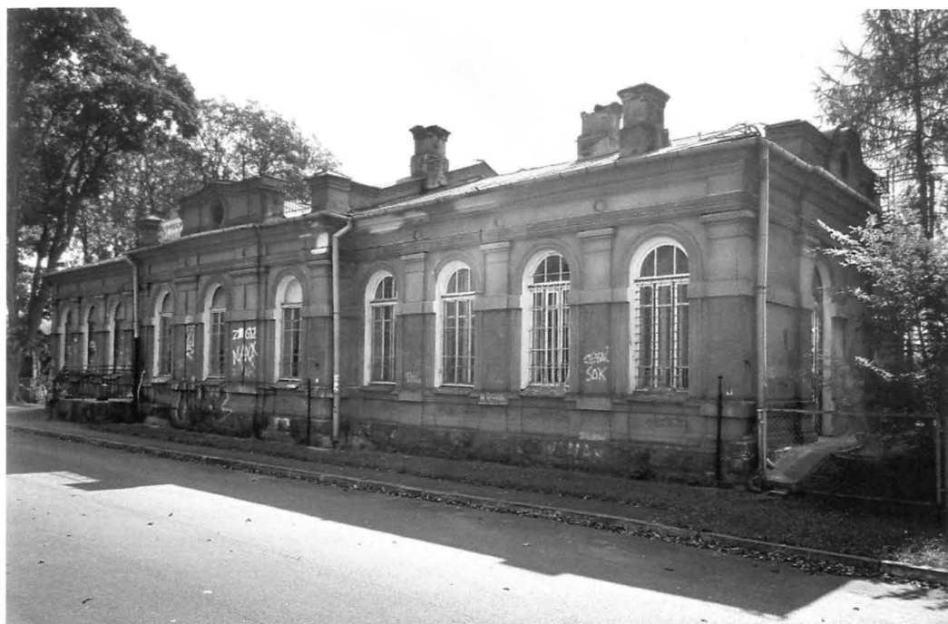
14. Nurzec Stacja, elewacja północna dworca kolejowego. Fot. K. Straczyński, 2013. Nurzec-Stacja, northern elevation of the railway station. Photo: K. Straczyński, 2013.
