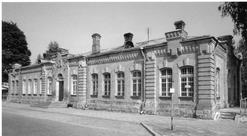
10. Augustów, dworzec kolejowy od strony południowej. Fot. K. Straczyński, 2013. Augustów, railway station from the south. Photo: K. Straczyński, 2013.
