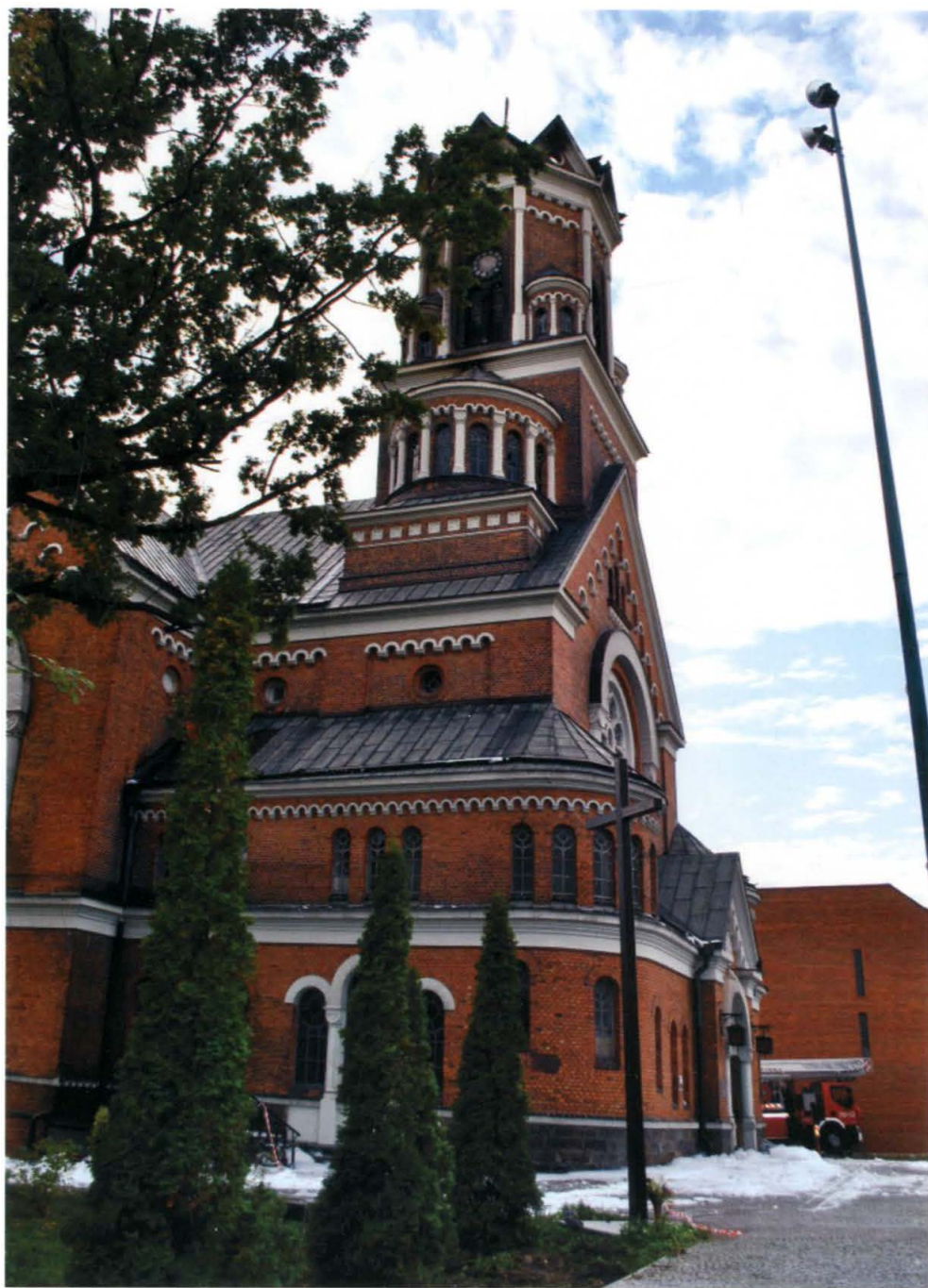
8. Wieża, widok od pld., stan po zawaleniu helmu wieży. Fot. I. Górską, 15.09.2013 r., NID OT Białystok.
