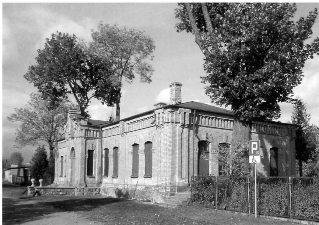
9. Nowa Kamienna, elewacja zachodnia dworca kolejowego. Fot. K. Straczyński, 2012. Nowa Kamienna, western elevation of the railway station. Photo: K. Straczyński, 2012.
