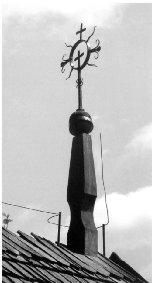
9. Profilowany pazdur na dachu kaplicy. Fot. J. Drozdowska, 2013. Profiled decoration on the shrine roof. Photo: J. Drozdowska, 2013.
