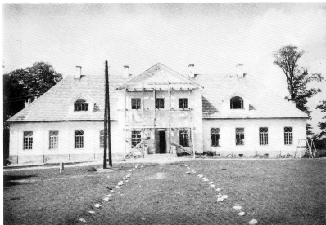
18. Elewacja frontowa pałacu w Strabli w trakcie remontu. Fot. Władysław Paszkowski, 1957
