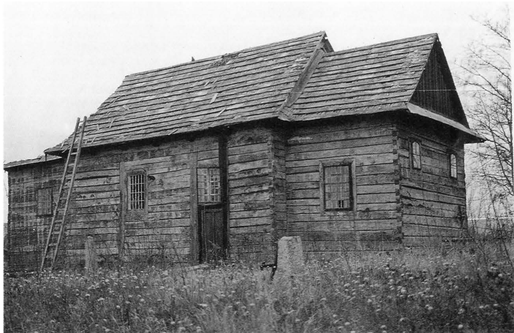
3. Narew. Cerkiew cmentarna w trakcie rozbiórki, stan z 30 października 1993 r. Fot. Barbara Tomecka
