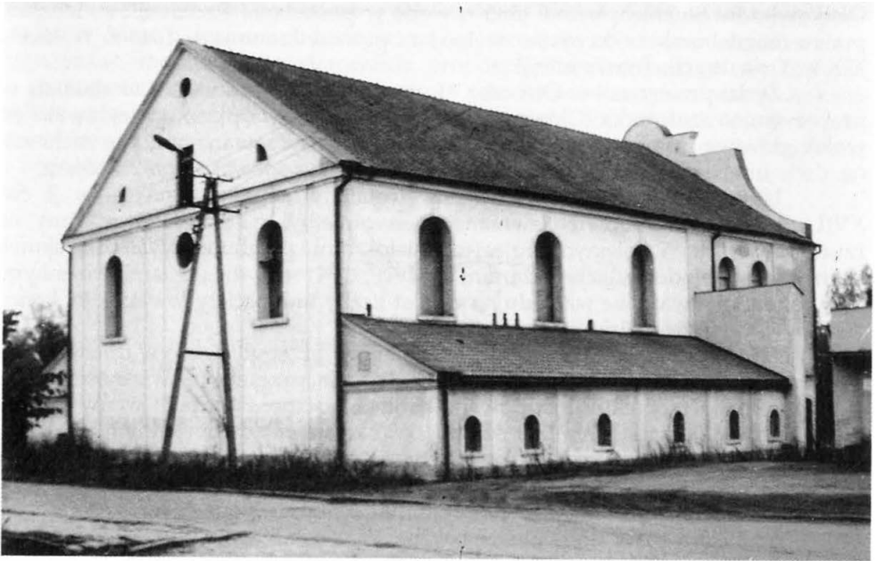
2. Widok na elewację tylną i boczną. Fot. Dariusz Stankiewicz (1994 r.)
