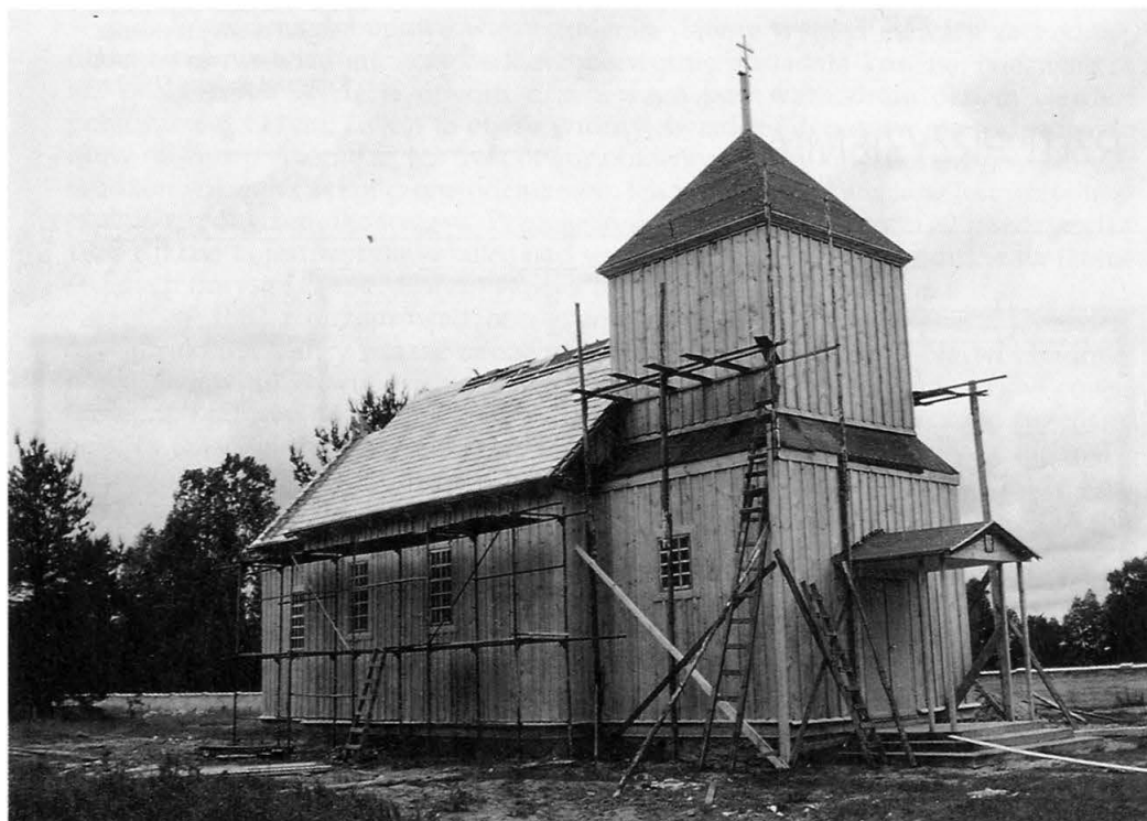
4. Narew. Cerkiew cmentarna po przeniesieniu, w trakcie prac wykończeniowych. Fot. Barbara Tomecka (5 czerwca 1994 r.)
