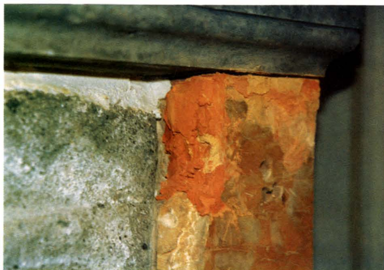
5. Nagrobek J. K. Branickiego - fragment cokołu w trakcie konserwacji - nakładanie kitów o różnych odcieniach żółci.
