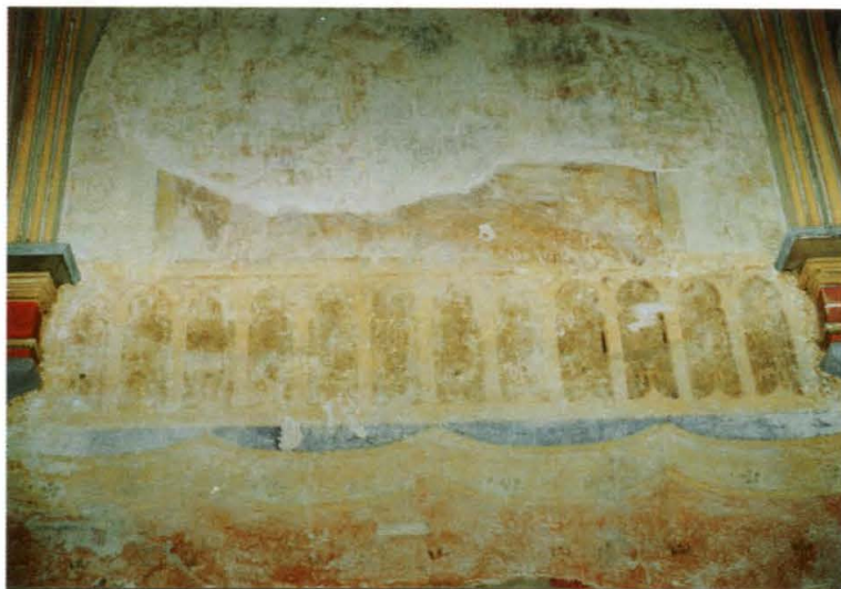
9. Wyszki. Fragment ściany w prezbiterium po usunięciu przemalowania.
