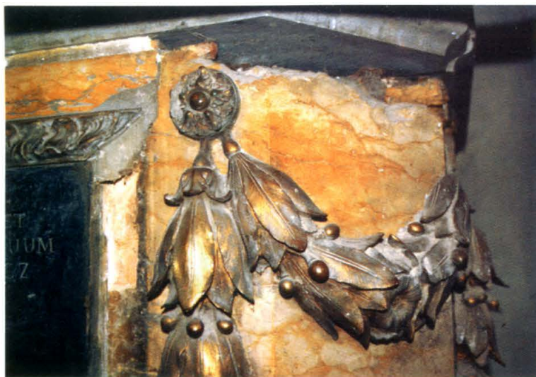
3. Nagrobek J. K. Branickiego - fragment cokołu, stan przed konserwacją. Tombstone of J. K. Branicki - fragment of the socle, state prior to conservation.
