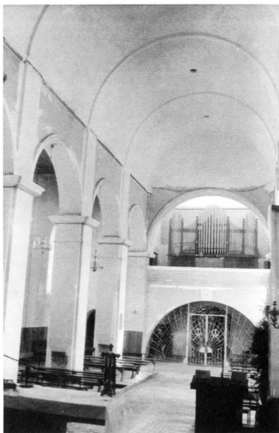
3. Kościół parafialny w Kuźnicy Białostockiej, wewnątrz w trakcie remontu prowadzonego w latach 1994-1996.
