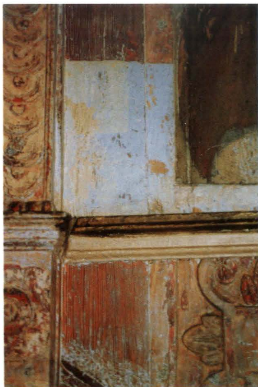
5. Ambona - fragment kosza w trakcie usuwania prze-malowań olejnych z widoczną warstwą jasnoniebieską z XIX w. Pulpit – fragment of basket during the removal of oil over-painting with visible light-blue layer from the nineteenth century. Fot. J. Polaska, 1996
