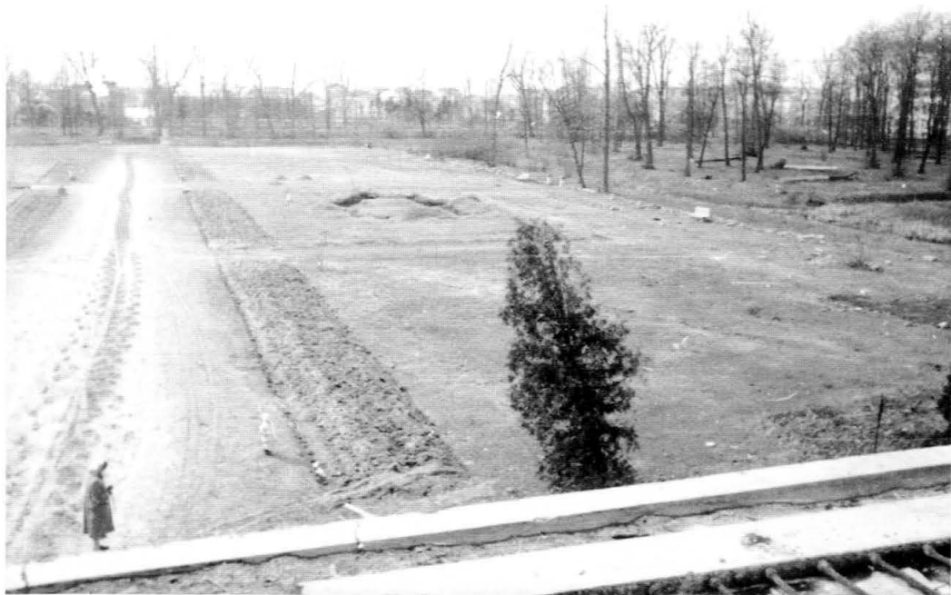
3. Ogród Branickich w Białymstoku. Widok z tarasu ogrodowego pałacu na teren parterów po wycięciu drzew, a przed wytyczeniem i obsadzeniem parterów. Z prawej widoczne wykopy pod basen fontanny.
