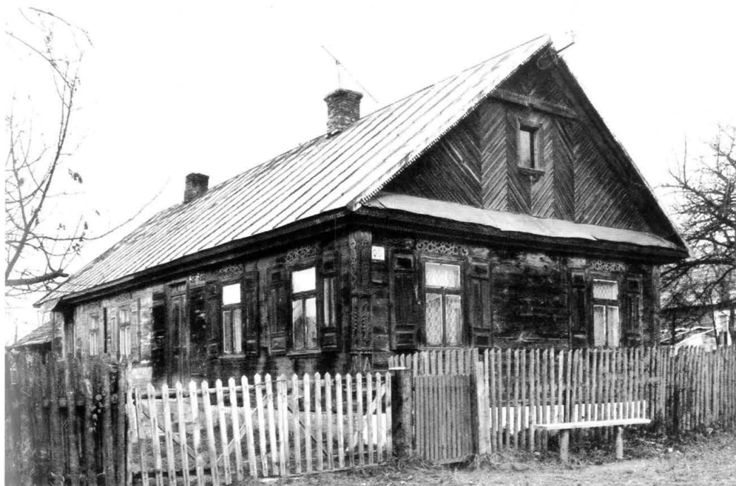
18. Ryboły – dom z ok. 1930 roku, dwurodzinny o układzie wzdłużnym: część mieszkalna - sieni - część mieszkalna - sieni.
