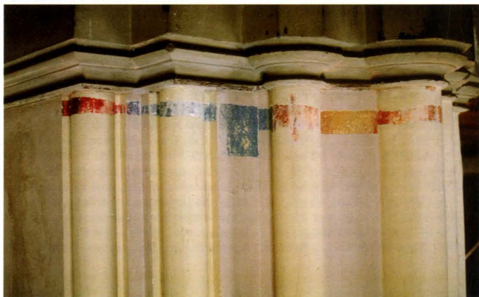
3. Łubin Kościelny. Odkrywki na filarze w kościele. Łubin Kościelny. Findings of the church pillar. Fot. Krzysztof Stawecki 1994
