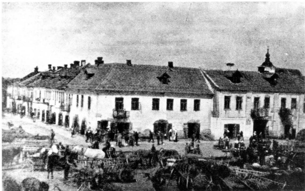
4. Siemiatycze. Południowa elewacja ratusza, początek XX w. (?). Fotografia ze zbiorów Jerzego Nowickiego. Siemiatycze. Southern elevation of town hall, beginning of the twentieth century (?). Photograph from the coll. of Jerzy Nowicki
