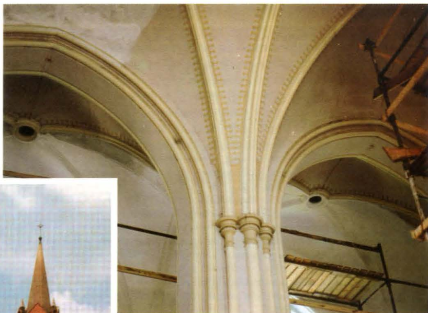
2. Łubin Kościelny. Sklepienie kościoła przed przywróceniem pierwotnej kolorystyki. Łubin Kościelny. Church vault of prior to the restoration of the original colour scheme. Fot. Krzysztof Stawecki 1994
