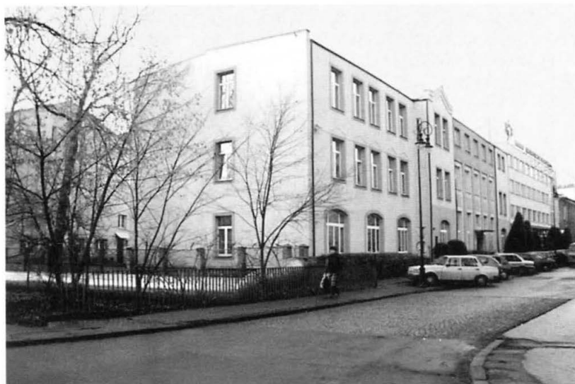
12. Widok na budynek administracyjny elektrowni z ul. Elektrycznej. Fot. A. Oleksicki, listopad 2000
