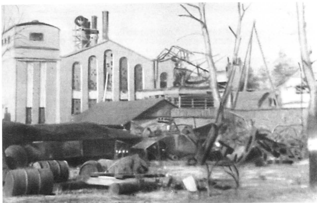
7. Zniszczona elektrownia, stan w 1944 r. Zwraca uwagę kompletnie zrujnowana hala maszyn. Repr. z Kroniki..., str. 47 Devastated electrical power plant, state in 1944. Attention is drawn to the completely ruined machine hall. Reprod. from Kronika..., p. 47
