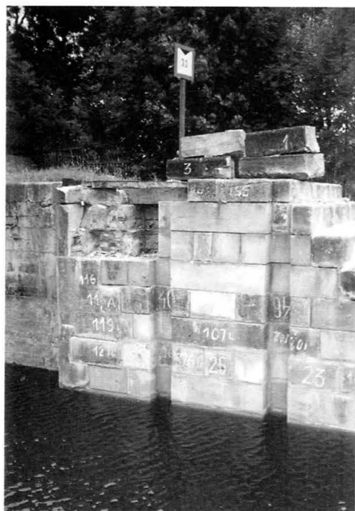
8. Śluza w Dębowie, oznaczone bloki piaskowca głowy dolnej przygotowane do demontażu. Fot. M. Ambrosiewicz, 1998 r. Lock in Dębowa, marked blocks of sandstone for the lower head, prepared for dismantling. Photo: M. Ambrosiewicz, 1998
