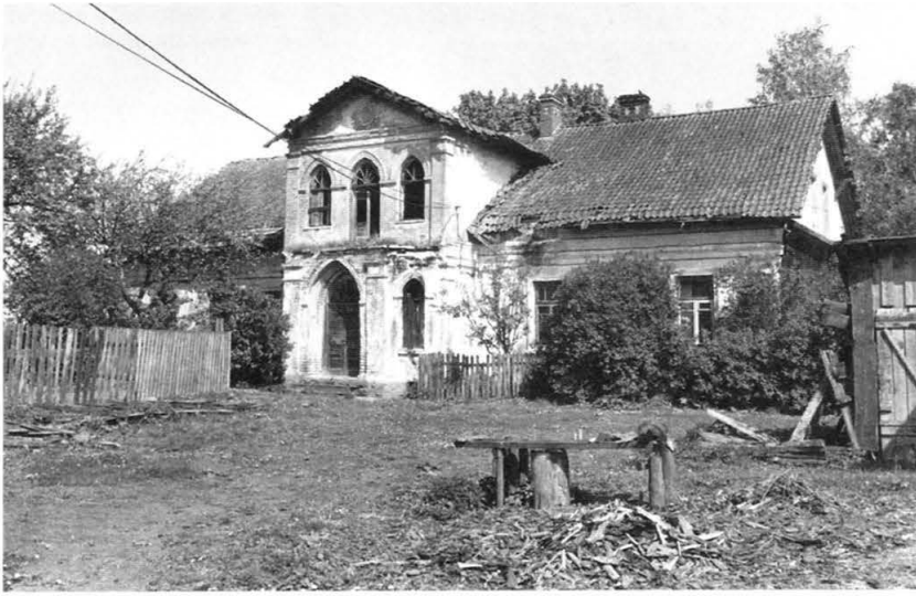
1. Niewodnica Nargilewska, dwór, fasada, stan z 1981 r. Fot. W. Hulanicki
