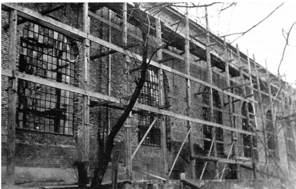
8. Odbudowa maszynowni, fot. z ok. 1945-46 r. Widać tu, że powtórzone dokładnie rytm i rozwiązania istniejące w obiekcie przed zniszczeniem. Repr. z Kroniki..., str. 55 Reconstruction of the engine room, photograph from about 1945-1946. The rhythm and solutions existing in the object prior to its destruction were copied precisely. Reprod. from Kronika..., p. 55
