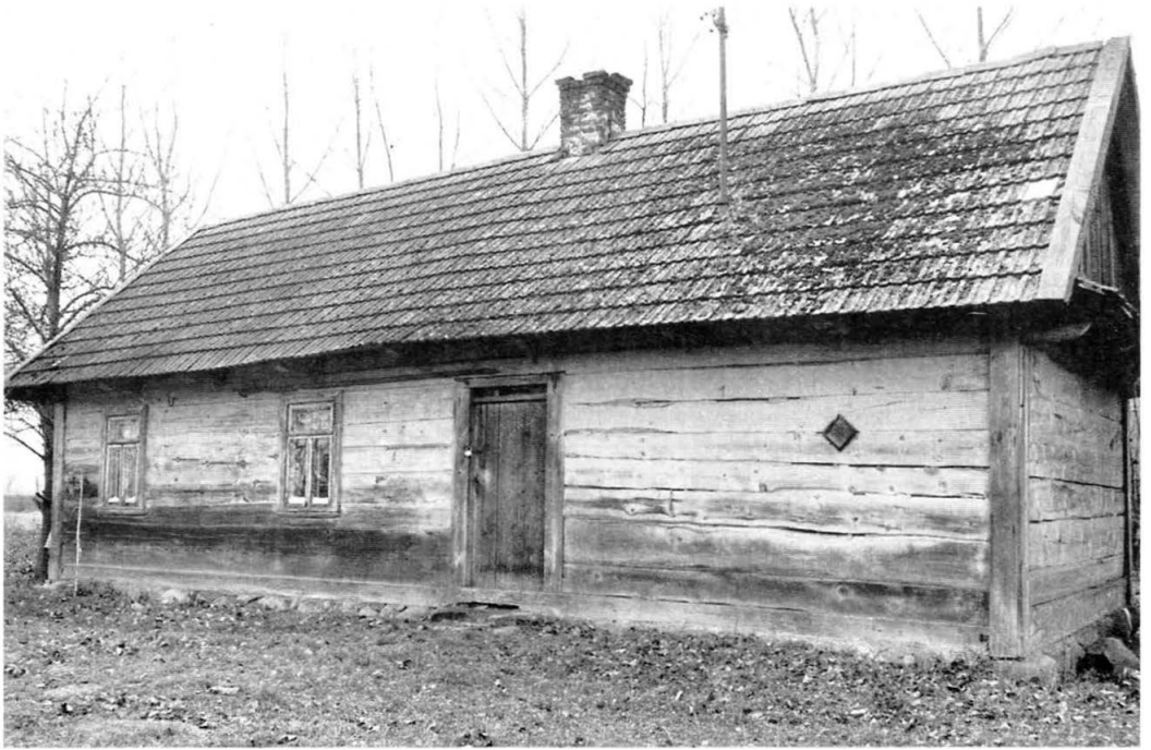
5. Trześcianka, gm. Narew, dom z komorą od strony ulicy (ściana szczytowa od ulicy bez okien). Fot. A. Sadowska, 1985, ze zbiorów WO SOZ w Białymstoku
