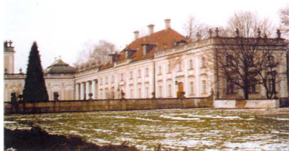
42. Prawa oficyna pałacu Branickich, stan styczeń 2000 r. Fot. E. Narolewska Right outbuilding of the Branicki palace, state in January 2000. Photo: E. Narolewska
