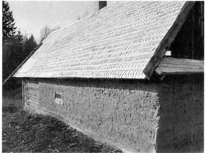
1. Bajnia w Piotrowej Dąbrowie po pracach remontowych, stan wrzesień 2000. Wszystkie zdjęcia: Maciej Kamiński Bathroom in Piotrowa Dąbrowa after repair, state in September 2000. All photos: Maciej Kamiński
