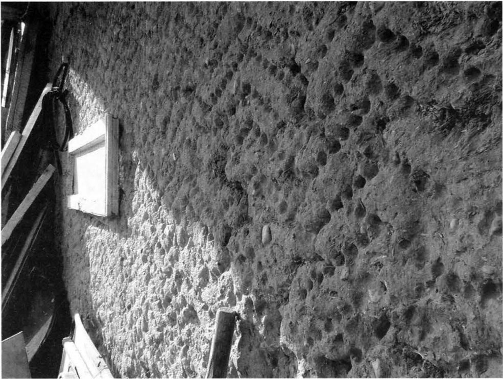
4. Fragment ściany z glinobitki, Rosochaty Róg, sierpień 2000. Fragment of a clay wall, Rosochaty Róg, August 2000.
