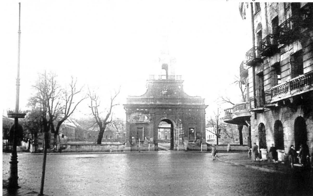
38. Wielka Brama w zespole pałacowo-ogrodowym Branickich z narożnikiem hotelu „Ritz”, stan 1948 r. Fot. W. Paszkowski, SOZ B-stok, neg. M/27/2410/1-3 View of the Great Gate in the Branicki palace-garden complex with a corner of hotel „Ritz”. State in 1948. Photo: W. Paszkowski, SOZ Białystok, negative: M/27/2410/1-3
