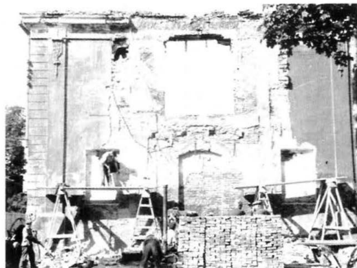
35. Wschodnia elewacja lewej oficyny pałacu Branickich, widoczne ślady po rozebranej przybudówce, stan 1947 r. Fot. W. Paszkowski, SOZ B-stok, neg. M/25/2163/5 Eastern elevation of the left outbuilding of the Branicki palace, visible traces of the pulled down annex, state in 1947. Photo: W. Paszkowski, SOZ Białystok, negative: M/25/2163/5
