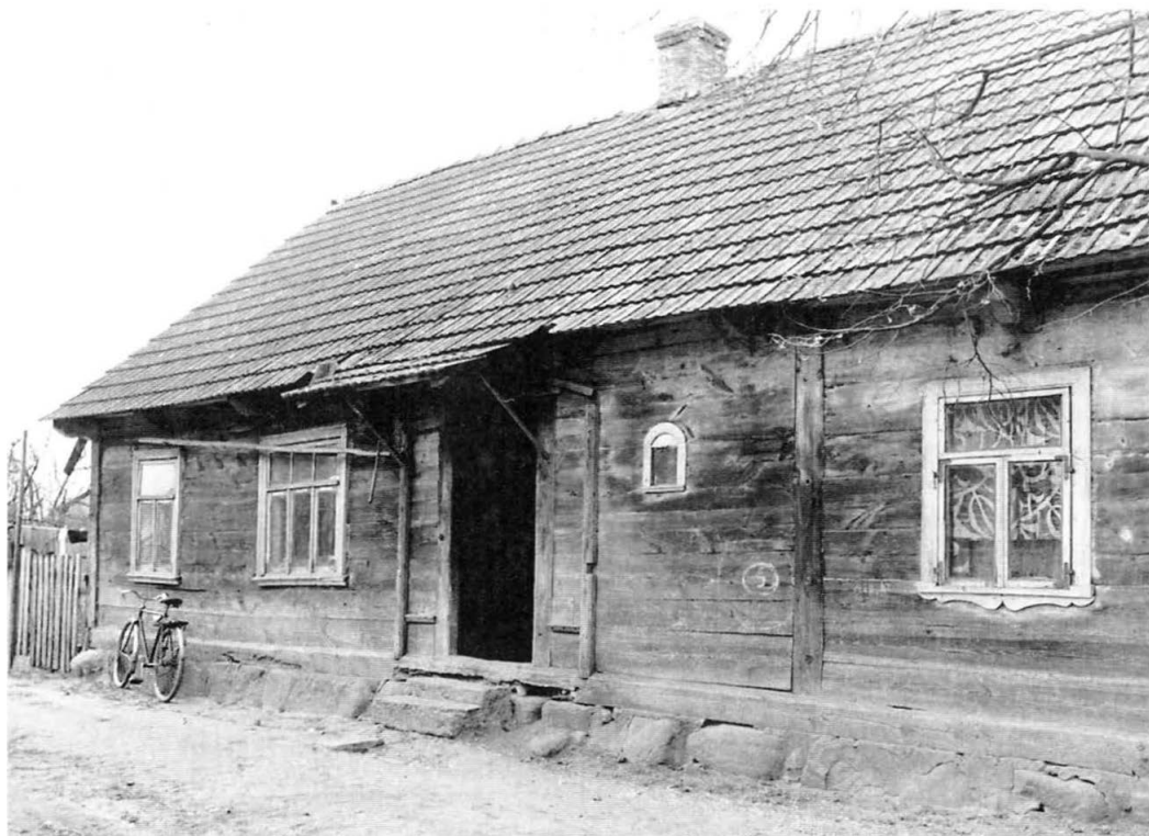
10. Trześcianka, gm. Narew, dom w konstrukcji mieszanej: zrębowej wspomaganiej sumikowo-łątkową, fundament z kamieni łączonych zaprawą. Fot. A. Sadowska 1985, ze zbiorów WO SOZ w Białymstoku Trześcianka, commune of Narew, house with mixed construction, frame supported by beam-post, foundation made of stones bound with mortar. Photo: A. Sadowska, 1985, from the coll. of WO SOZ in Białystok
