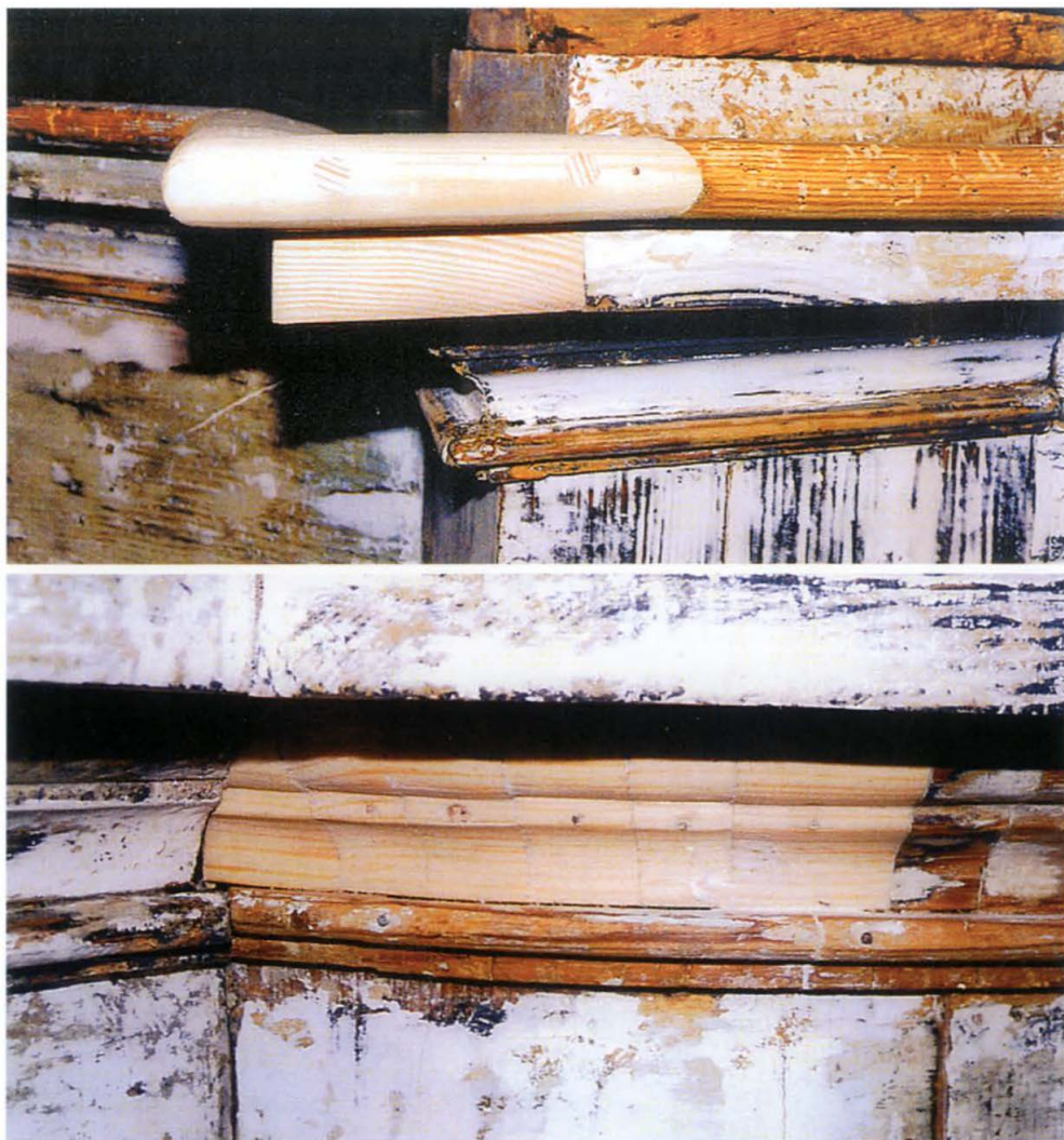
11-12. Fragmenty gzymsów środkowej partii szafy organowej po uzupełnieniu ubytków snycerki. Fragments of cornices in the middle part of the organ case after supplementing gaps in the woodcarving.
