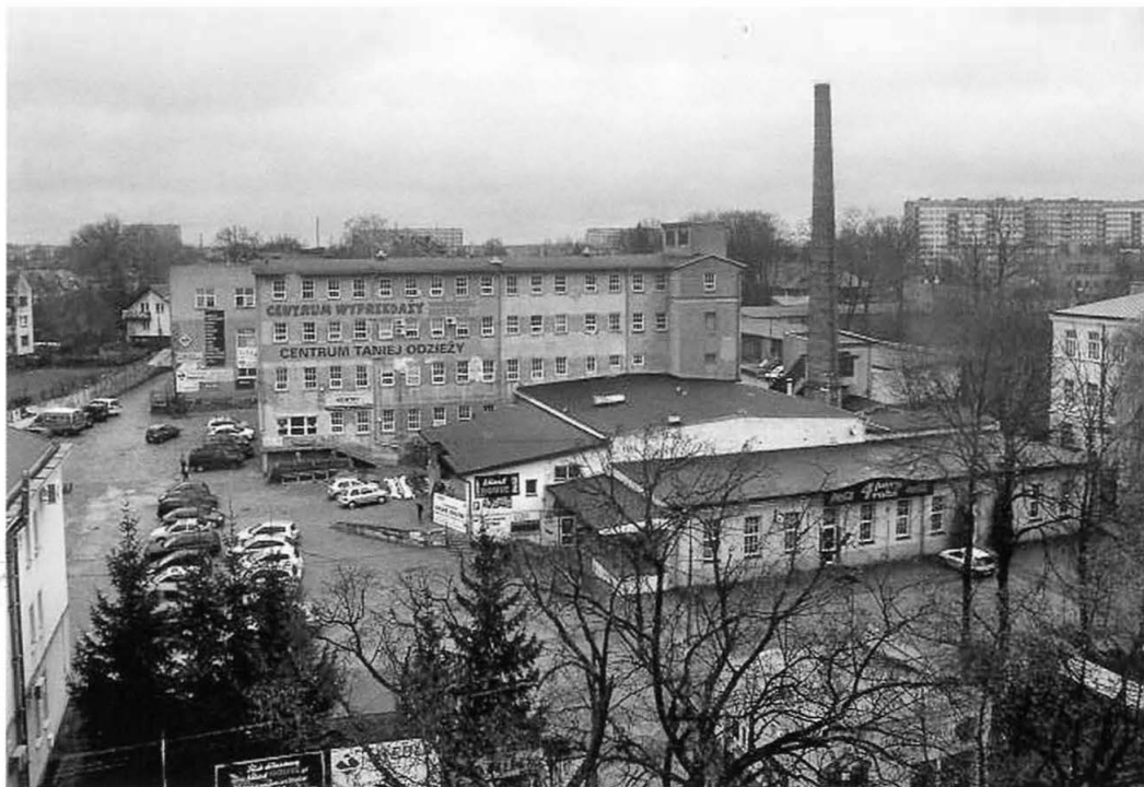
19. Zespół pofabryczny przy ul. Warszawskiej 59 w Białymstoku – widok ogólny z wieży kościoła pw. św. Wojciecha. Fot. S. Wicher, XI 2010 r. Post-factory complex in 59 Warszawska Street in Białystok – general view from the tower of the church of St. Wojciech. Photo: S. Wicher, November 2010.
