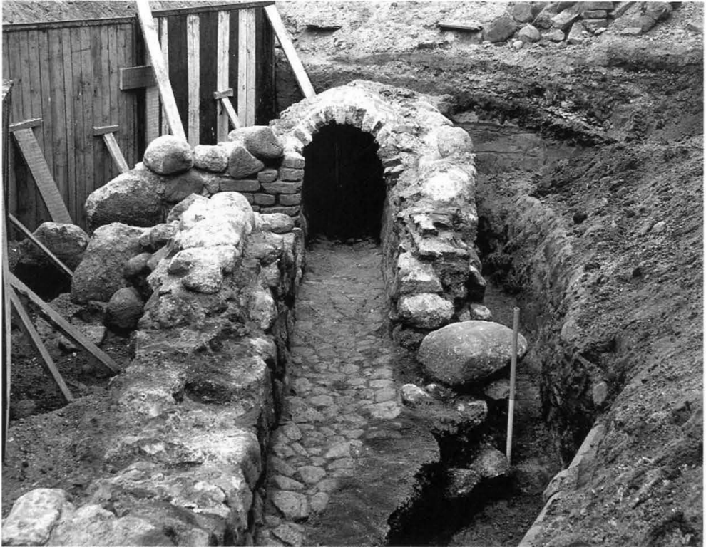
12. Białystok, stan. 1 – Ogród Branickich, wykopy przy Galerii „Arsenal”. Odsłonięte relikty murowanego kanału sanitarnego. Fot. L. Pawlata. Białystok, site 1 – the Branicki garden, digs next to the “Arsenal” Gallery. Unearthed relics of the brick sanitary canal. Photo: L. Pawlata.
