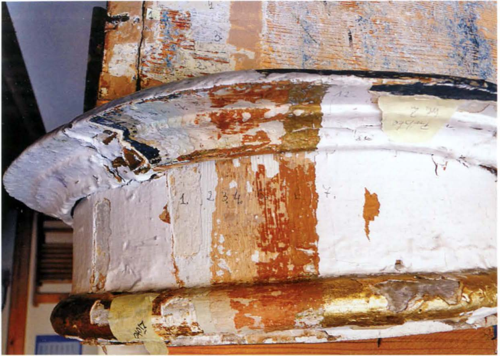
5-6. Fragment dolnej obudowy puszczalek środkowej wieży i boku dolnej partii szafy.
