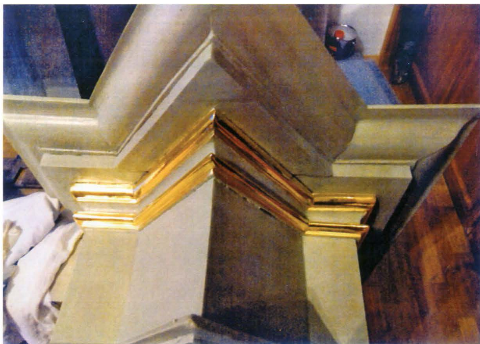
20. Fragment górnego gzymsu szafy organowej. Stan po konserwacji. Fragment of the upper cornice of the organ case. State after conservation.
