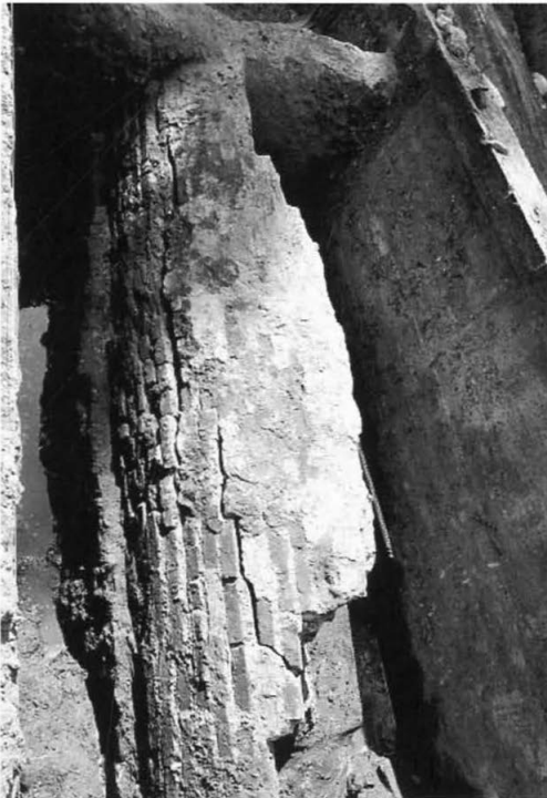
6. Zachowany fragment ceglanego tunelu w tzw. Ogrodzie Chińskim (wykop 1). Widok z góry. Fot. M. Kozieł. Preserved fragment of a brick tunnel in the so-called Chinese Garden (dig 1). View from the top. Photo: M. Kozieł.
