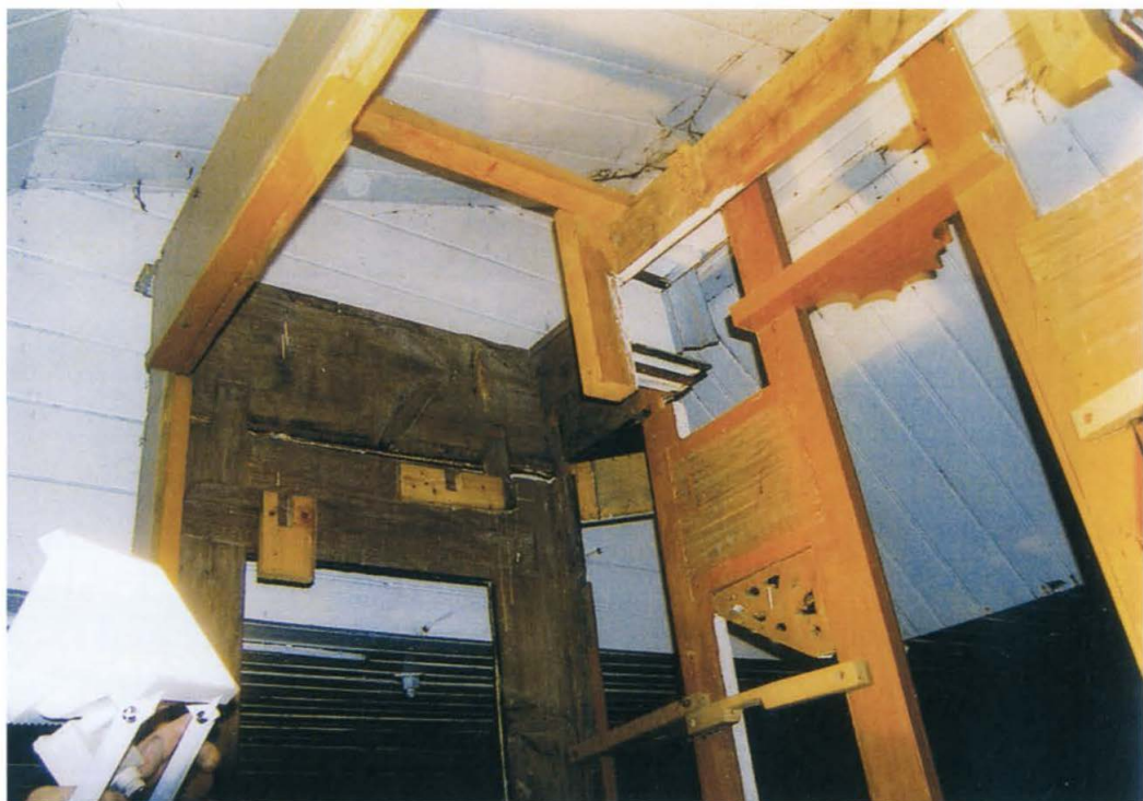
3-4. Górna i dolna część wnętrza szafy organowej w trakcie demontażu. Stan przed konserwacją. Upper and lower part of the interior of the organ case in the course of disassembly. State prior to conservation.
