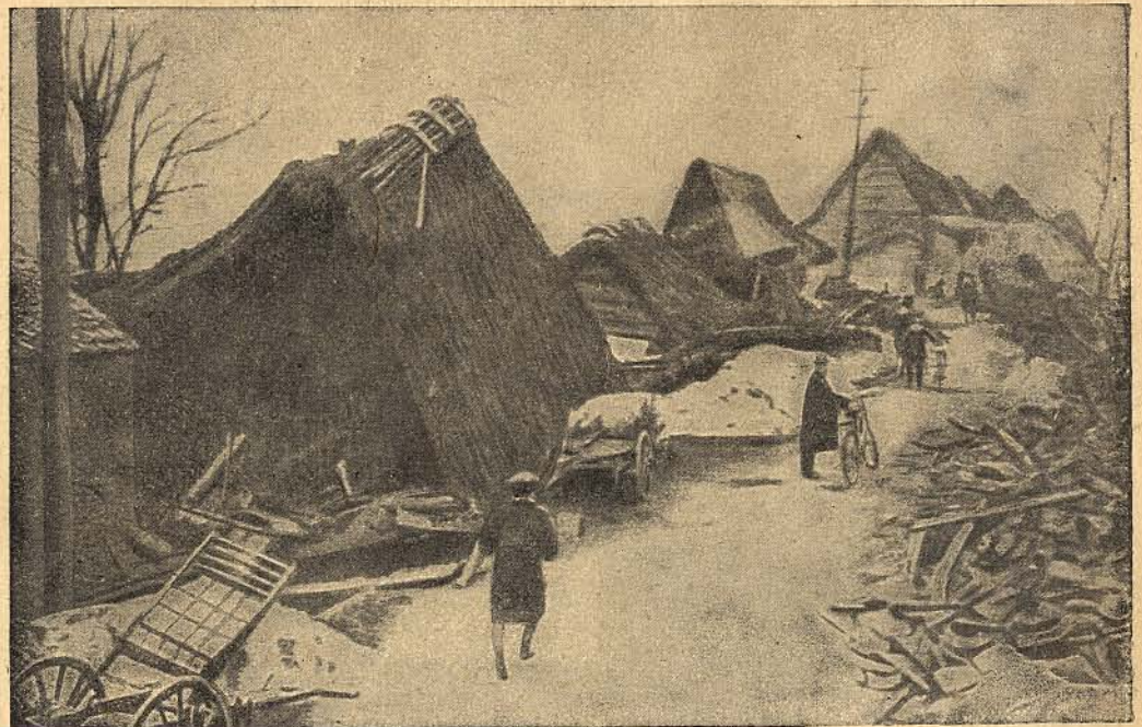
Trzęsienie ziemi w Japonji. = Zniszczona wieś. — Podczas trzęsienia ziemi zginęło 5000 ludzi. Rozwaliło się 4.580 domów a 3.480 domów spłonęło.
