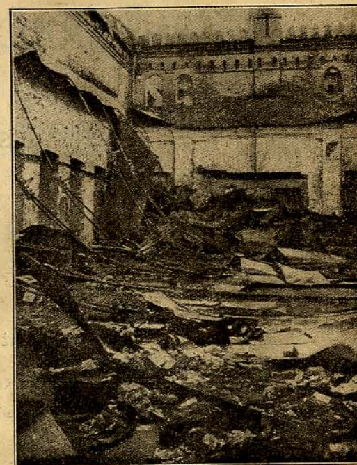
Zniszczony przez Rosjan dworzec w Brześciu.
