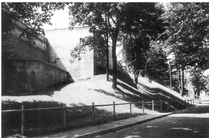
12. Północny stok wzgórza wigierskiego, zbocze zostało ukształtowane zgodnie z biegiem ścieżek prowadzących do budynku gospodarczego znajdującego się na tarasie dolnym. Fot. M. Ambrosiewicz, 1999 r. Northern slope of the Wigry hillock, shaped in accordance with the course of paths leading to the outbuilding in the lower terrace. Photo: M. Ambrosiewicz 1999
