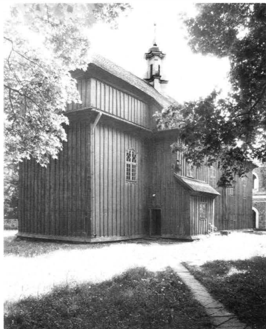
2. Elewacja wschodnia i północna. Fot. Andrzej Stasiak, 1979 r. Eastern and northern façade. Photo: A. Stasiak 1979
