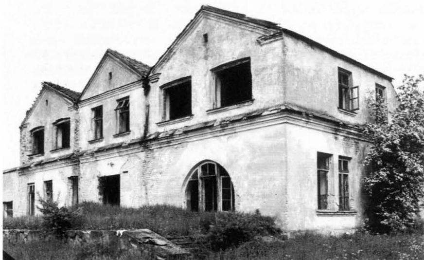
2. Elewacja południowa i wschodnia. Fot. J. Tołoczko, 1999
