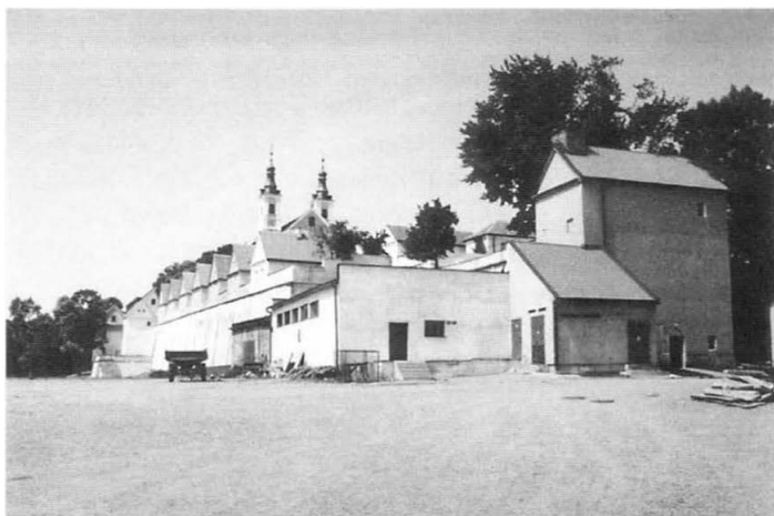
10. Widok na zespół od wschodu, na pierwszym planie budynek kotłowni. Fot. M. Ambrosiewicz, 1999 r. View of the complex to the east, in the foreground: building of the boiler house. Photo: M. Ambrosiewicz 1999
