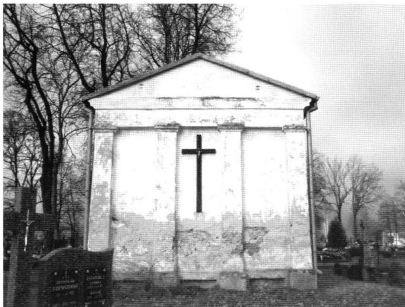
5. Elewacja południowa kaplicy, 2006. Southern elevation of the chapel, 2006.
