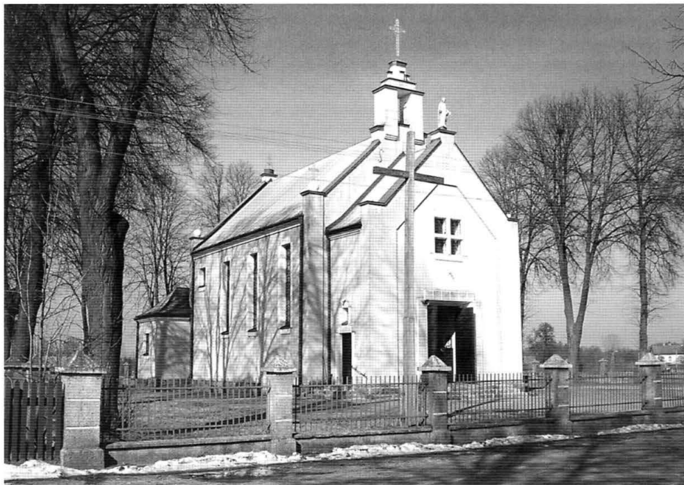
5. Kościół parafialny pw. Matki Bożej Królowej Polski w Niemyjach Nowych. Widok na fasadę i elewację południowo- zachodnią. Wszystkie fotografie współczesne kościoła wykonał autor artykułu w marcu 2007 r. Parish church of the Madonna, the Queen of Poland in Niemyje Nowe. View of the facade and the south-western elevation. All contemporary photographs were taken by the author of the article in March 2007.
