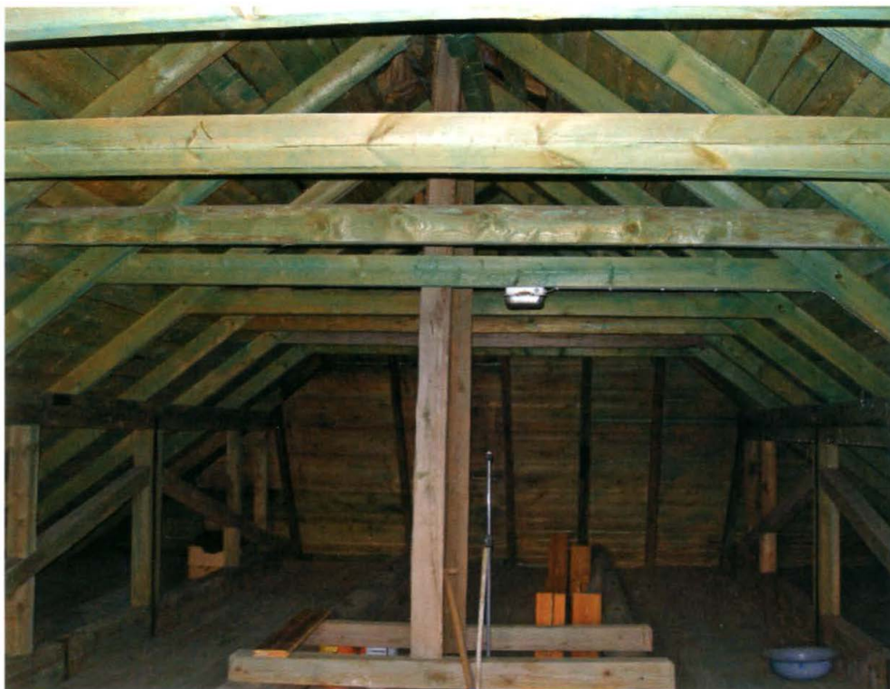
41. Widok ogólny na więźbę dachową. Fot. A. Płocka, 2007 r. General view of the roof truss. Photo: A. Płocka, 2007.
