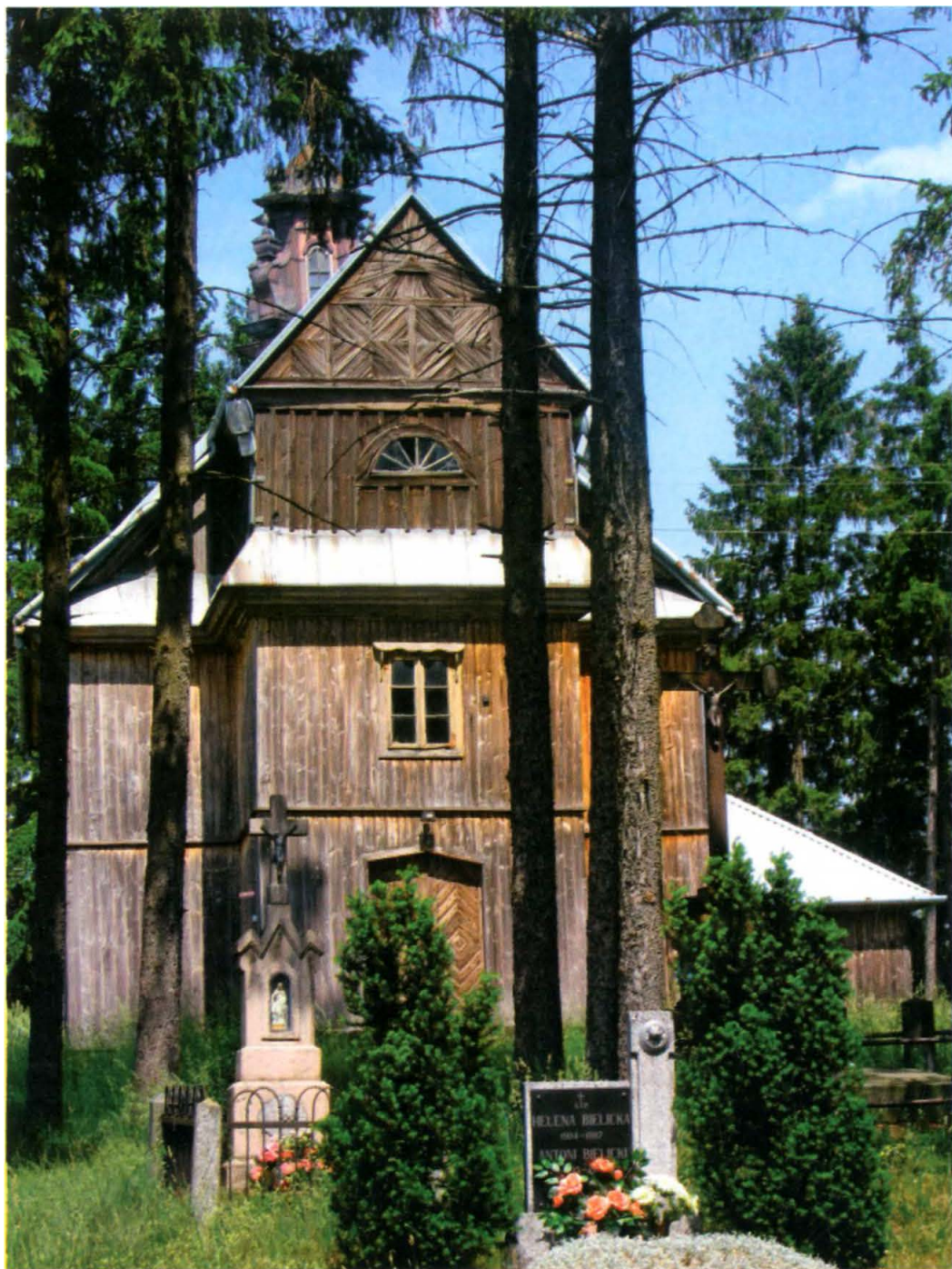
3. Kościół cmentarny pw. Podwyższenia Krzyża Świętego, widok na elewację frontową. Cemetery church of the Elevation of the Holy Cross, view of the front elevation.
