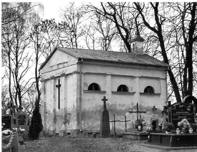
3. Widok na elewację wschodnią kaplicy, 2007.
