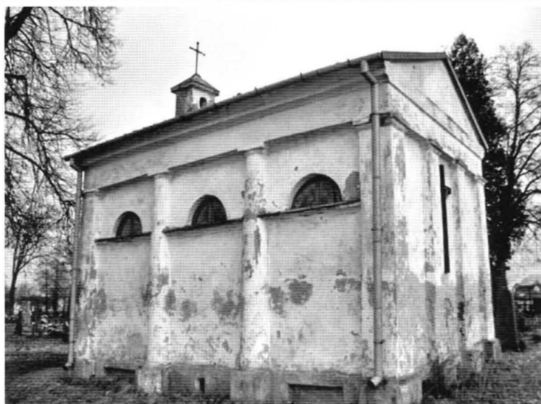
4. Widok na elewację zachodnią kaplicy, 2006.
