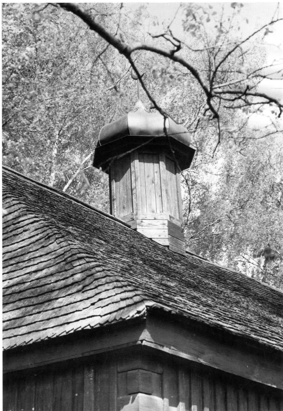
20. Meczet w Kruszynianach. Wieżyczka w kalenicy dachu. Fot. J. Szandomirski, 1976 r., M. Petsch, op. cit. Mosque in Kruszyniany. Turret on the roof ridge. Photo: J. Szandomirski, 1976; M. Petsch, op. cit.
