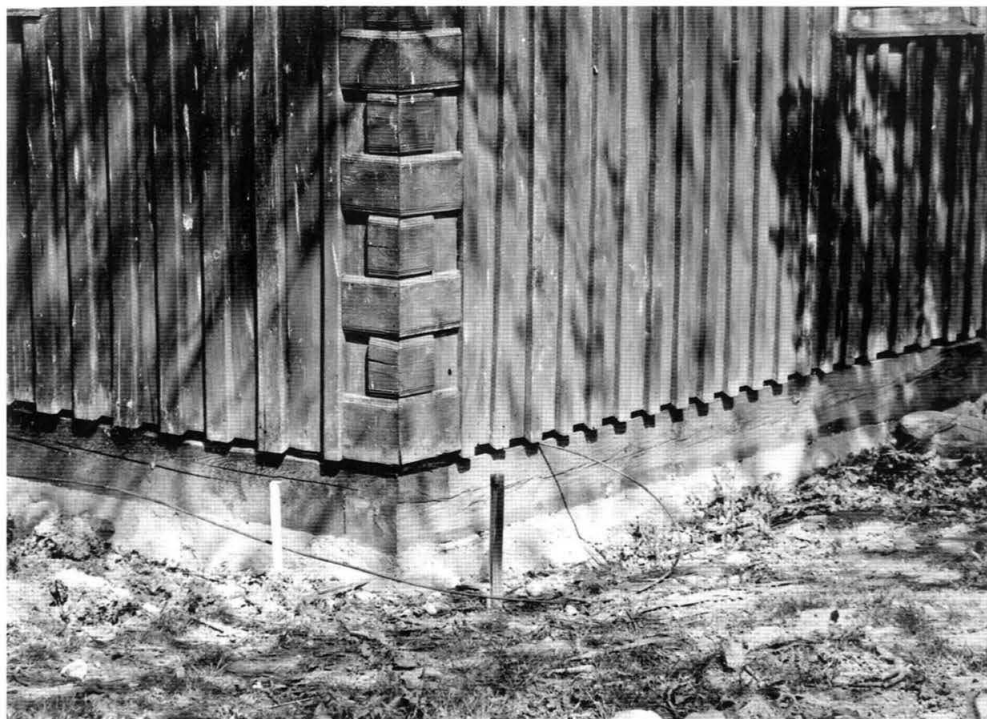
21. Belka podwaliny w narożniku północno-wschodnim. Fot. J. Szandomirski, 1976 r., M. Petsch, op. cit. Foundation beam in the northeastern corner. Photo: J. Szandomirski, 1976; M. Petsch, op. cit.
