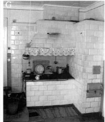
7. Piec o układzie dwuramiennym. A. Husaki w gm. Bielsk Podlaski. B. Wólka w gm. Juchnowiec. C. Woronie w gm. Bielsk Podlaski. D. Mielezki w gm. Gródek. E. Deniski w gm. Bielsk Podlaski. F. Kożany w gm. Juchnowiec. G. Mierzwin Mały w gm. Wyszki. Fot. A. - J. Szewczyk, pozostałe fot. - studenci W.A. P.B. Stove with a two-arm configuration. A. Husaki, commune of Bielsk Podlaski. B. Wólka, commune of Juchnowiec. C. Woronie, commune of Bielsk Podlaski. D. Mielezki, commune of Gródek. E. Deniski, commune of Bielsk Podlaski. F. Kożany, commune of Juchnowiec. G. Mierzwin Mały, commune of Wyszki. Photo A: J. Szewczyk, other photos: students from the Department of Architecture at the Białystok Polytechnic.
