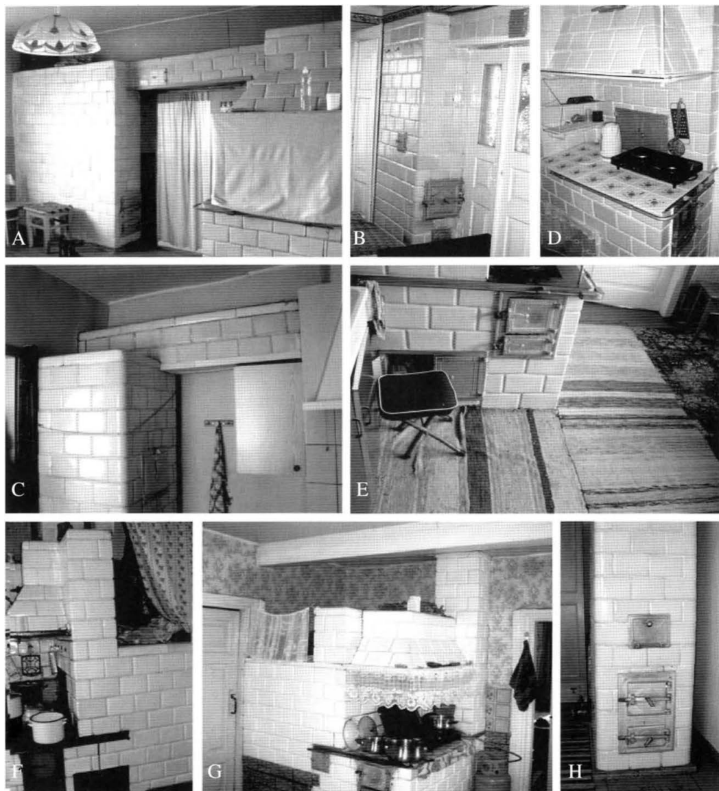
10. Szczegóły rozwiązań podlaskich systemów piecowych. A. Leżak podsufitowy łączący piec, we wsi Słoja w gm. Szudziałowo. B. jw., ale we wsi Wojszki w gm. Juchnowiec. C. jw., ale we wsi Żółtki w gm. Tykocin. D. Archaiczne umieszczenie wlotu pieca chlebowego nad płytą paleniskową, we wsi Plutycze w gm. Bielsk Podlaski (pod piecem zaś jest skrytka na drwa). E. Piec do wypieku chleba u dołu trzona piecowego, Koszele w gm. Orla. F. Zapiecek magazynowy (nie sypialny) we wsi Chomontowce w gm. Gródek. G. jw., ale we wsi Kołty w gm. Bielsk Podlaski. H. Fragment słupka grzejnego we wsi Chytra w gm. Hajnówka. Fot. studenci W.A. P.B. Details of solutions applied in Podlasie stove systems. A. Ceiling flue linking stoves in the village of Słoja, commune of Szudziałowo. B. Vide supra but also in the village of Wojszki, commune of Juchnowiec. C. Vide supra but also in the village Żółtki, commune of Tykocin. D. Archaic installation of a bread stove inlet above the plate in the village of Plutycze, commune of Bielsk Podlaski (a wood container is situated under the stove). E. Bread stove at the bottom of the stove core, Koszele, commune of Orla. F. Storage zapiecek (not used for sleeping) in the village of Chomontowce, commune of Gródek. G. Vide supra but in the village of Kołty, commune of Bielsk Podlaski. H. Fragment of a heating pillar in the village of Chytra, commune of Bielsk Podlaski.
