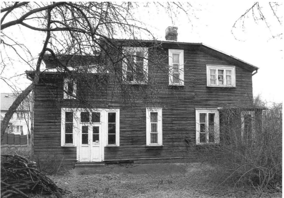
4. Elewacja tylna (północno-zachodnia). Fot. S. Wicher, 2008 r. Back (north-western) elevation. Photo: S. Wicher 2008.
