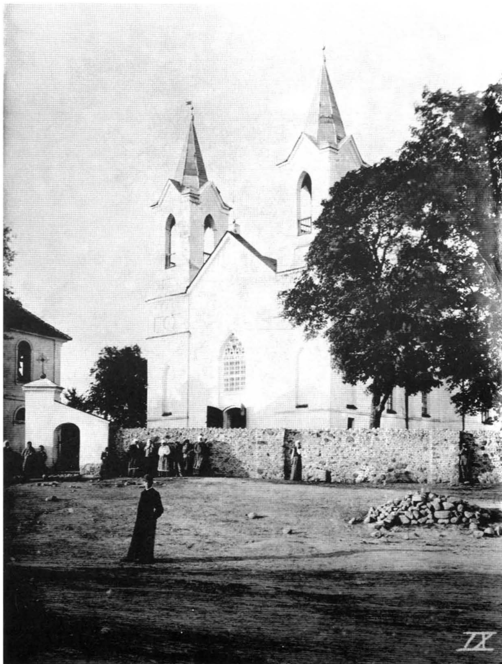
10. Kościół pw. św. Jana Chrzciciela w Nowym Dworze. Church of St. John the Baptist in Nowy Dwór.
