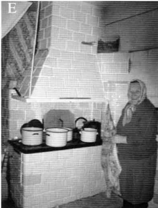
7. Piec o układzie dwuramiennym. A. Husaki w gm. Bielsk Podlaski. B. Wólka w gm. Juchnowiec. C. Woronie w gm. Bielsk Podlaski. D. Mielezki w gm. Gródek. E. Deniski w gm. Bielsk Podlaski. F. Kożany w gm. Juchnowiec. G. Mierzwin Mały w gm. Wyszki. Fot. A. - J. Szewczyk, pozostałe fot. - studenci W.A. P.B. Stove with a two-arm configuration. A. Husaki, commune of Bielsk Podlaski. B. Wólka, commune of Juchnowiec. C. Woronie, commune of Bielsk Podlaski. D. Mielezki, commune of Gródek. E. Deniski, commune of Bielsk Podlaski. F. Kożany, commune of Juchnowiec. G. Mierzwin Mały, commune of Wyszki. Photo A: J. Szewczyk, other photos: students from the Department of Architecture at the Białystok Polytechnic.
