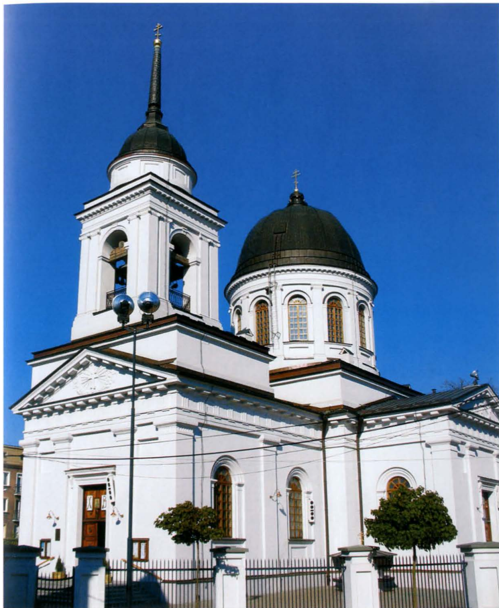
4. Sobór św. Mikołaja, widok na część zach. Fot. I. Górska, 2010. Eastern rite church of St. Nicholas, view of the western part. Photo: I. Górska, 2010.
