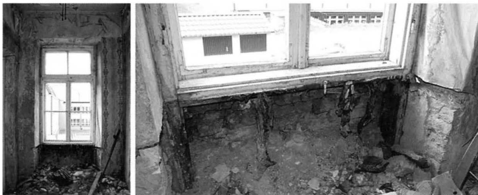
21. Widok na okno przebudowane z drzwi balkonowych. Widoczna ścianka zewnętrzna wymurowana do poziomu parapetu po wyburzeniu zewnętrznej, pionowe słupki futryny sięgające poniżej parapetu, fragment tynku na gładzie poniżej parapetu. Fot. K. Kulesza.
