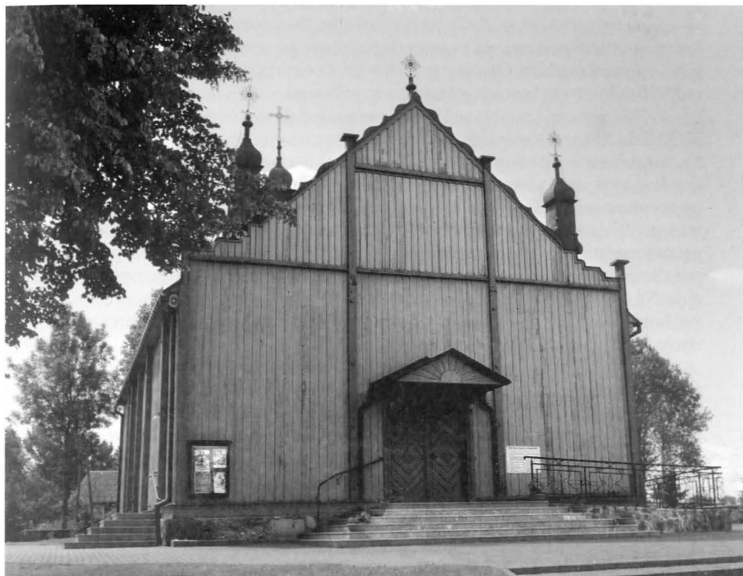
2. Domanowo, kościół parafialny pw. św. Doroty Męczenniczki, fasada. Fot. J. Kotyńska-Stetkiewicz, 2010 r. Domanowo, parish church of St. Dorothy the Martyr, facade. Photo: J. Kotyńska-Stetkiewicz, 2010.
