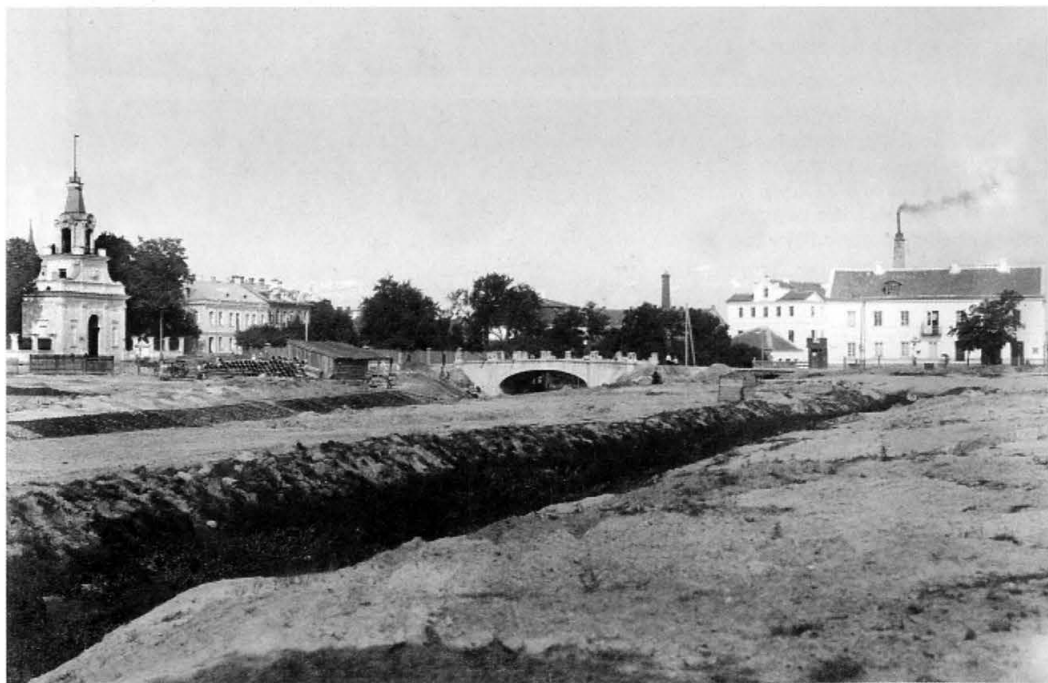
11. Osuszanie stawu przed pałacem Branickich. W głębi ogrodzenie ogrodu przy Pałacyku Gościnnym. Stan z końca XIX w. Fot. Jan Sołowiejczyk, 1897. Draining the pond in front of the Branicki Palace. In the background: fence of the garden next to the Guest Palace. Photo: Jan Sołowiejczyk, 1897.
