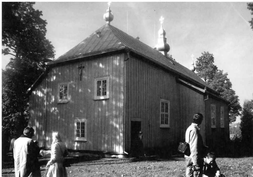
5. Ilguvá (Ilgów), drewniany kościół pw. Znalezienia Krzyża Świętego. Ilguvá (Ilgów), wooden church of the Discovery of the Holy Cross.
