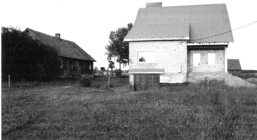
4. Drewniane domy z końca XIX w. są systematycznie rozbierane, a w ich miejsce buduje się nowe – murowane i bardziej okazałe: Krypno Wielkie, gm. Krypno, obok „starego” domu wyrósł już nowy.
