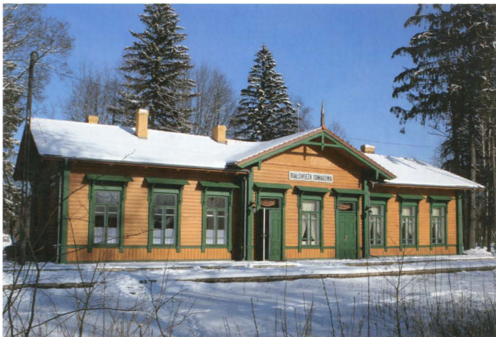
9. Elewacja południowo-zachodnia dworca. Fot. Janusz Korbel, 2005 r. Southwestern elevation of the train station. Photo: Janusz Korbel, 2005.
