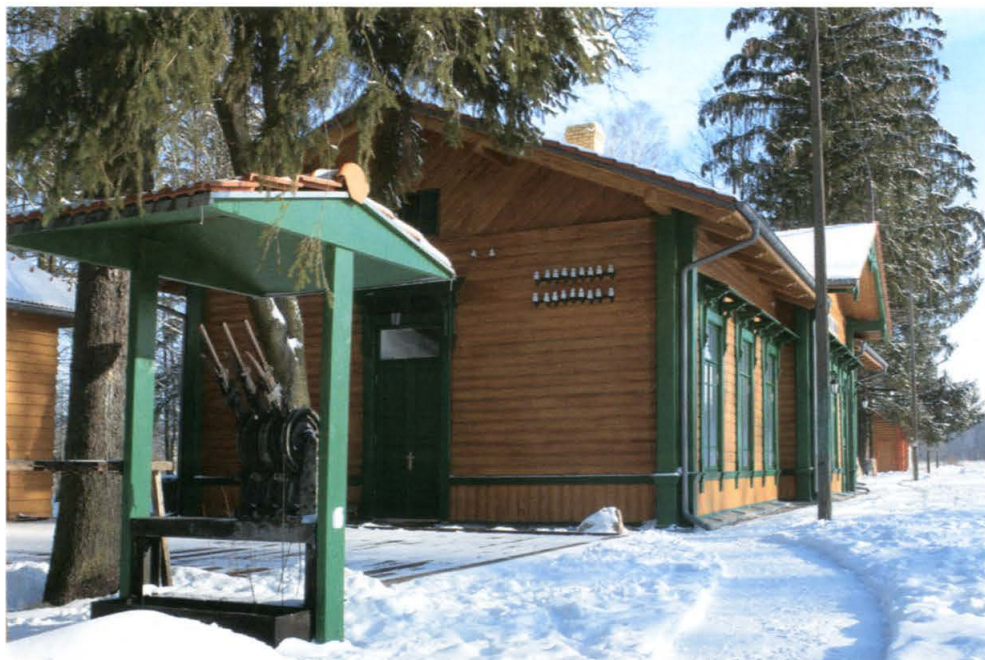
11. Elewacja północno-zachodnia i urządzenie techniczne (nastawnica) po przeprowadzonej konserwacji. Fot. Janusz Korbel, 2005 r.
