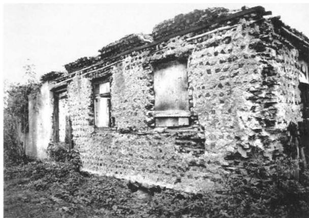
11. Dom z polan w Krynkach przy ul. Browarnej 4. Fot. Magdalena Rodziejewicz, maj 2002, Archiwum Zakładu Architektury i Planowania Wsi W.A. P.B. House made of wooden billets in Krynki, 14 Browarna Street. Photo: Magdalena Rodziejewicz, May 2002, Archive of the Faculty of Rural Architecture and Spatial Planning at the Department of Architecture at the Technical University of Białystok.
