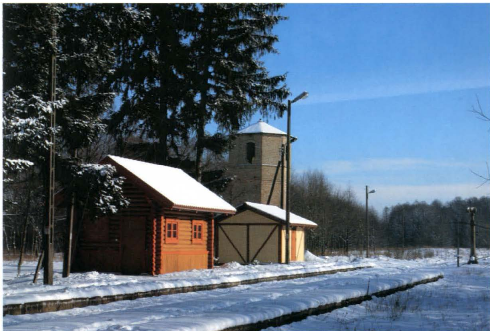
6. Budynki pomocnicze i wieża ciśnieni w zespole dworca kolejowego. Fot. Janusz Korbel, 2005 r. Auxiliary buildings and water tower in the train station complex. Photo: Janusz Korbel, 2005.
