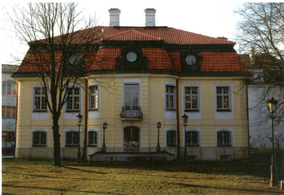
2. Pałac Gościnny w Białymstoku. Elewacja od strony ogrodu. Wszystkie zdjęcia wykonał Piotr Kętyś, 2005 r. Guest palace in Białystok. Elevation seen from the garden. All photos: Piotr Kętyś, 2005.
