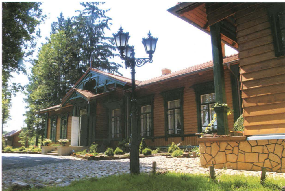
8. Dworzec kolejowy od strony północnej po przeprowadzonych pracach remontowo-konserwatorskich. Fot. Janusz Korbel, 2005 r. Train station from the north after repair-conservation. Photo: Janusz Korbel, 2005.
