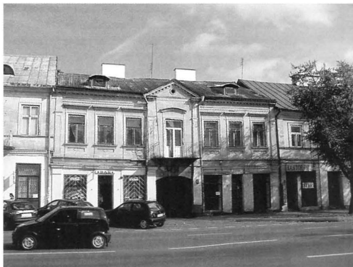
12. Budynek przy ulicy Kościuszki 82, przykład zabytku w złym stanie technicznym. Building in 82 Kościuszki Street – an example of a monument in bad technical condition.
