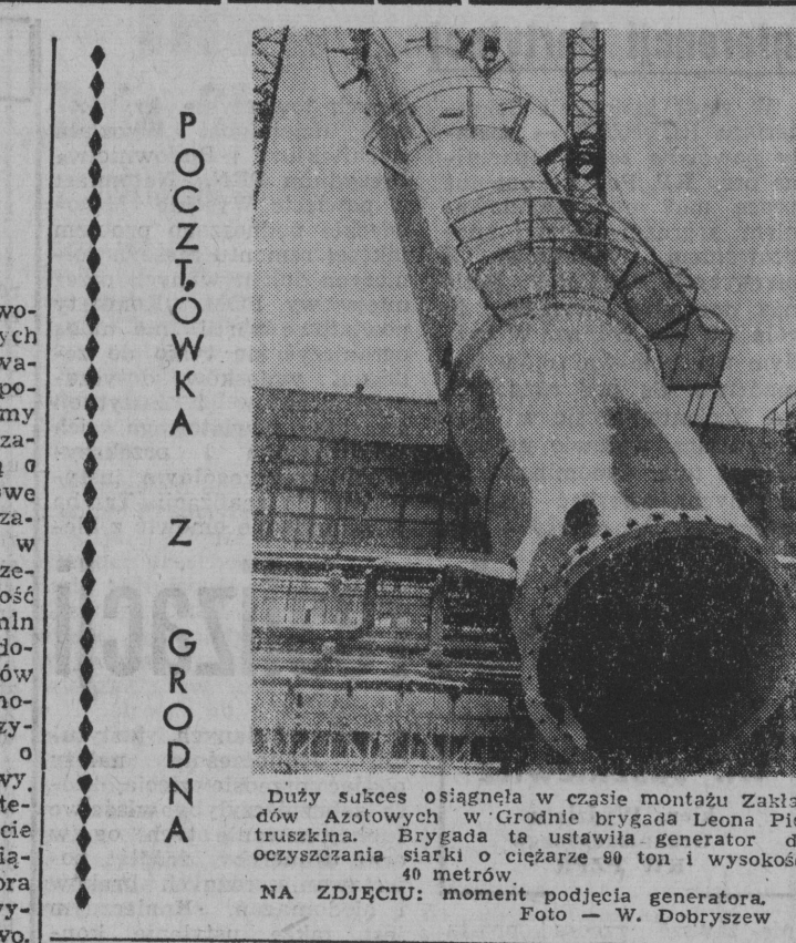
Nowy plac budowy
