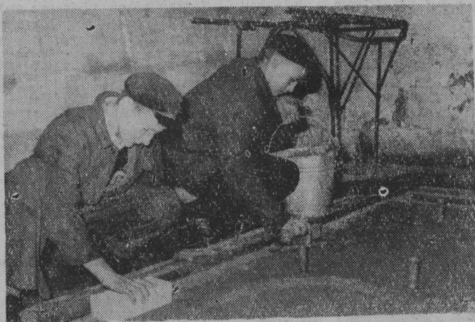
Antoni Lulewicz i Mikołaj Kunicki przy budowie fundamentu pod młot mechaniczny.
