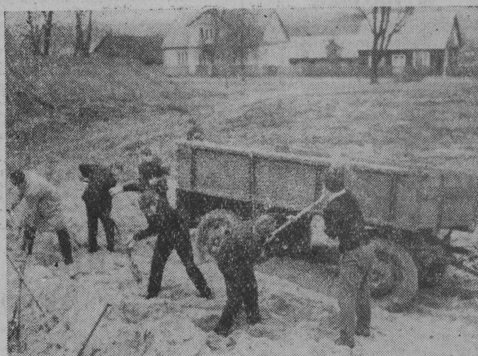
Prace przy budowie boisk sportowych.
