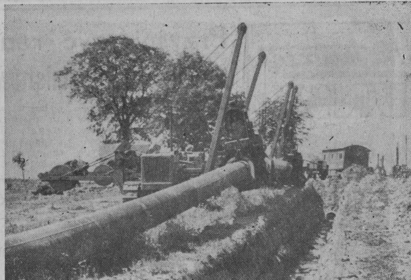
Fragment pracy przy układaniu rurociągu „Przyjaźń”.
