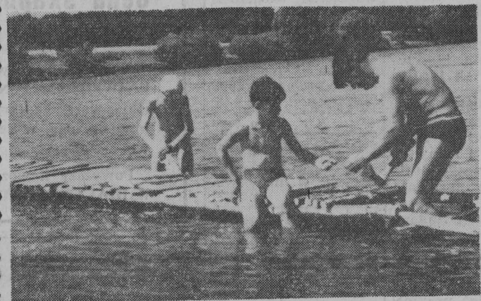
NA ZDJĘCIU: budowa pomostu.
