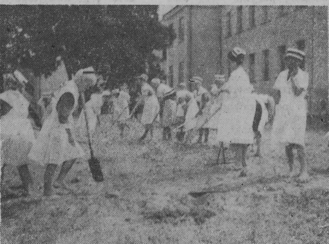
W tym miejscu będzie parking samochodowy wykonany w czynie społecznym przez pracowników Szpitala im. Śniadeckiego i mieszkańców Komitetu Blokowego nr 27.
