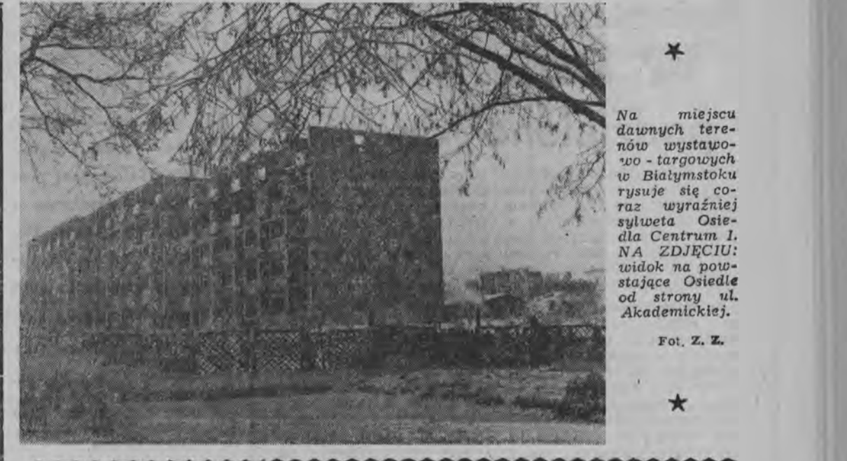
Na miejscu dawnych terenów wystawo-wo-targowych w Białymstoku rysuje się coraz wyraźniej sylwetka Ośrodka Centrum i... NA ZDZIECIU: uścisłok na powstające Osiedle od strony ul. Akademickiej.
