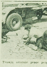
Trwają ostatnie prace przy poszerzaniu Al. 1 Maja.
